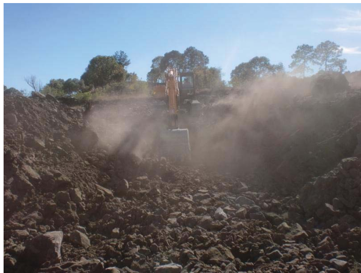
Fotografía 4.2.- Excavación para el desplante del muro. (Fuente: Propia, 2011).
