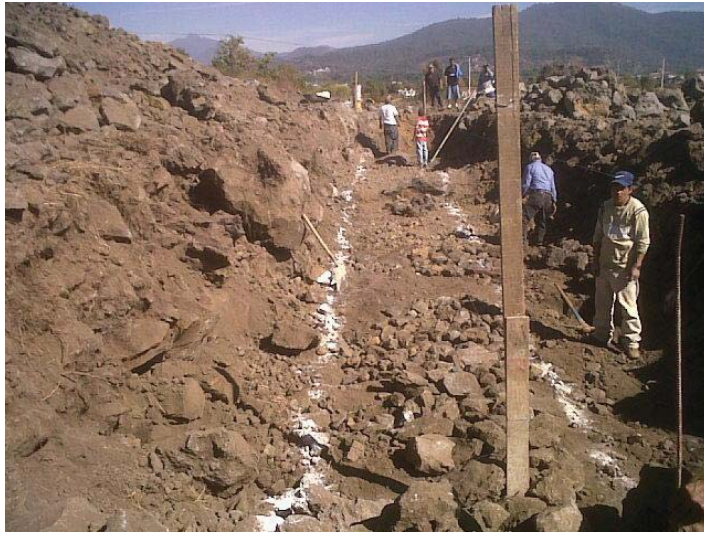
Fotografía 4.3.- Trazo del muro. (Fuente: Propia, 2011).
