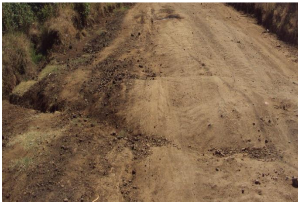
Fotografía 3.3.- Superficie de rodamiento.
