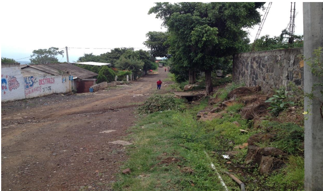
Imagen 3.2. Estado actual del camino.
