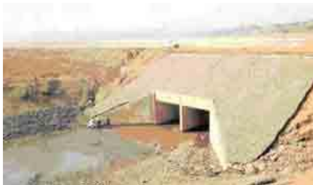
Imagen 2.7 Alcantarilla de cajón.
