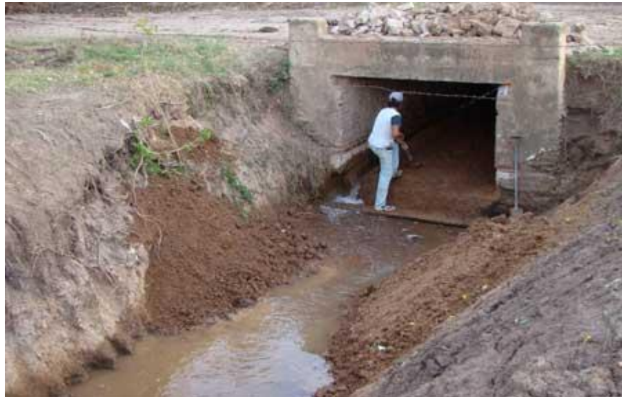
Imagen 2.6 Alcantarilla de losa.
