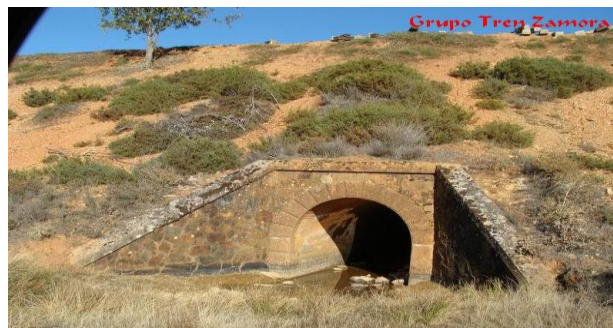
Imagen 2.5 Alcantarillas de bóveda.
