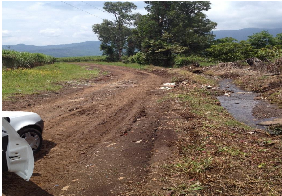
Imagen 3.1. Estado actual del camino
