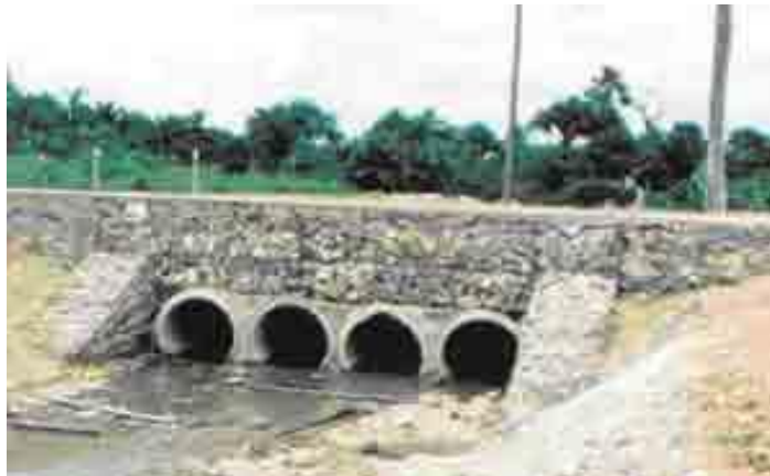
Imagen 2.4 Alcantarillas de tubo.
