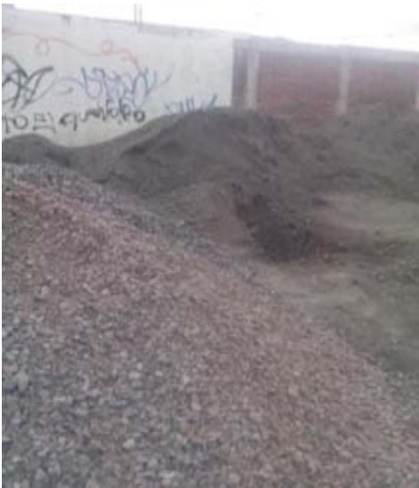
Fotografía: 3.5.- Base hidráulico
