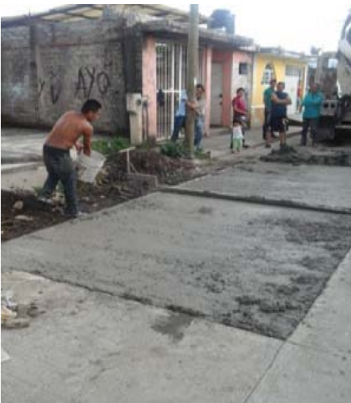
Fotografía: 3.12.- Aplicación de agua Para terminado. Fuente: Propia.
