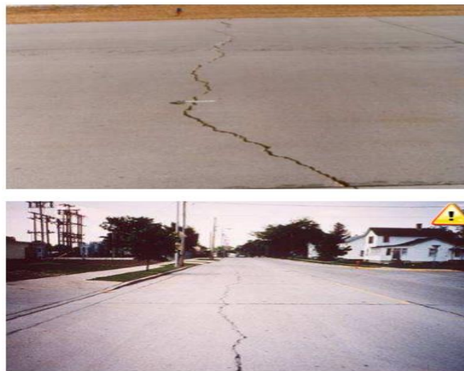
Figura: 2.16.- Fallas principales en pavimentos rígidos.
