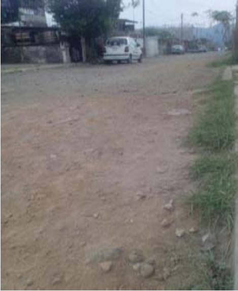
Fotografía: 3.3.- Terreno natural.
