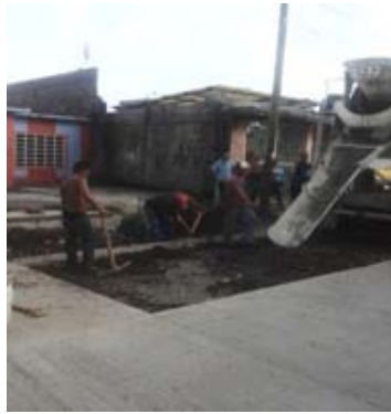
Fotografía: 5.4.- Vaciado de concreto.
