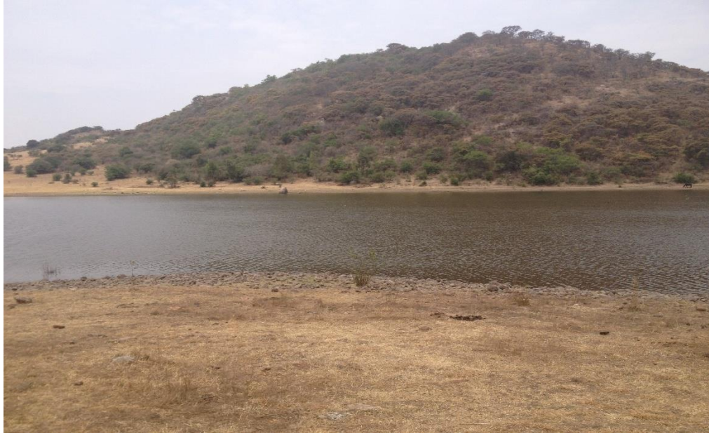
FOTO 3 PRESA LAS CANOAS
