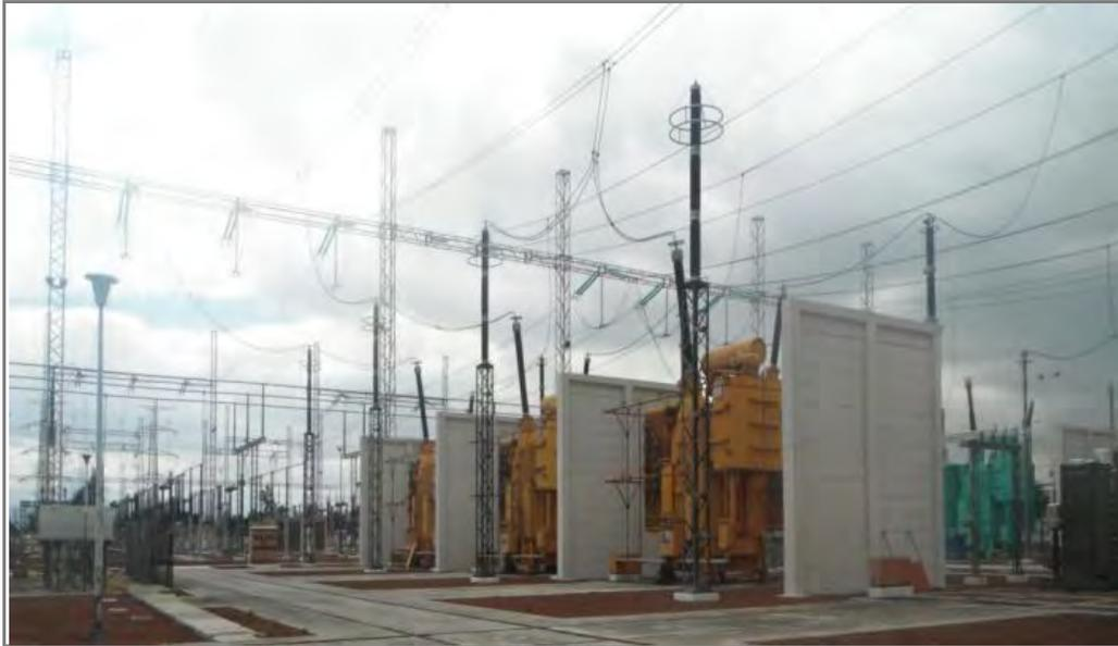
**Figura 1.10. Transformador de potencia**
