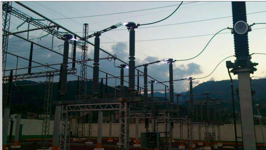
**Figura 1.16. Arco eléctrico producido al cerrar cuchillas de 230 kV con potencial durante maniobra normal**
