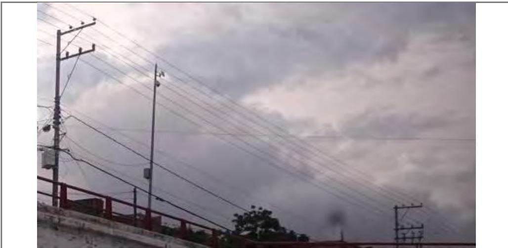
**Figura 1.13. Circuito de 13.8 kV por postes**
