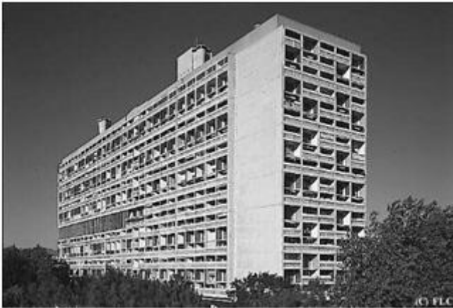
Fig.8. Unité d'Habitation, Marseille (1997)
