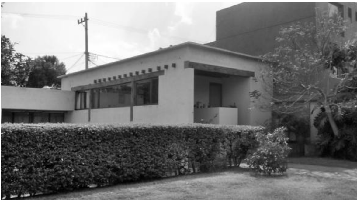
Perspectiva del edificio a intervenir (foto: archivo personal)
