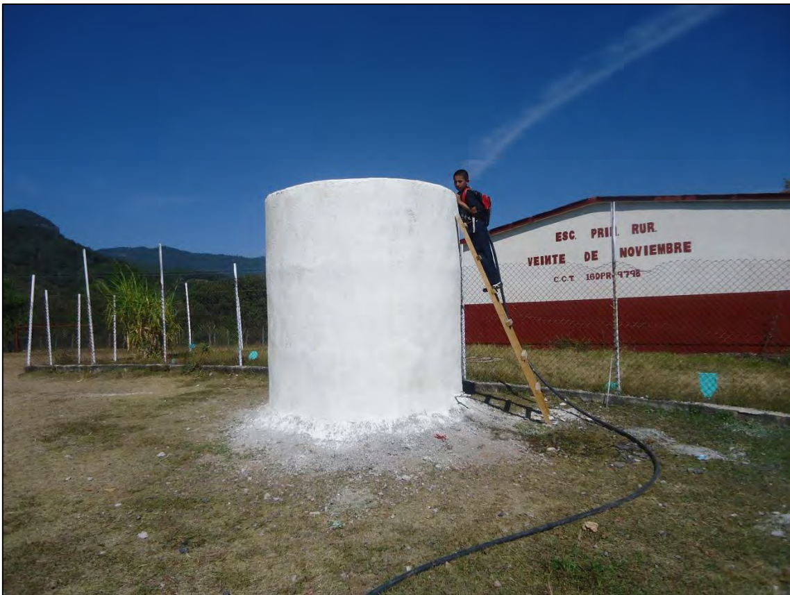
Fotografía 8: “Cisterna para 10,000 litros de agua, terminada”. Fuente: José Cruz.
