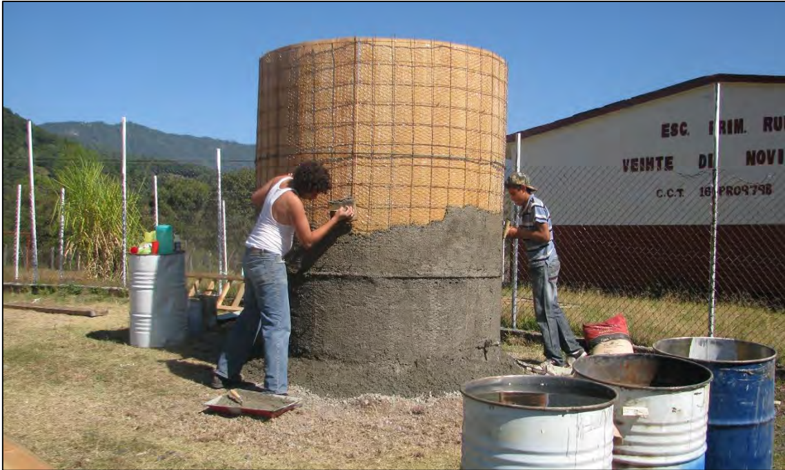
Fotografía 7 “Construyendo cisterna para la escuela primaria”.
