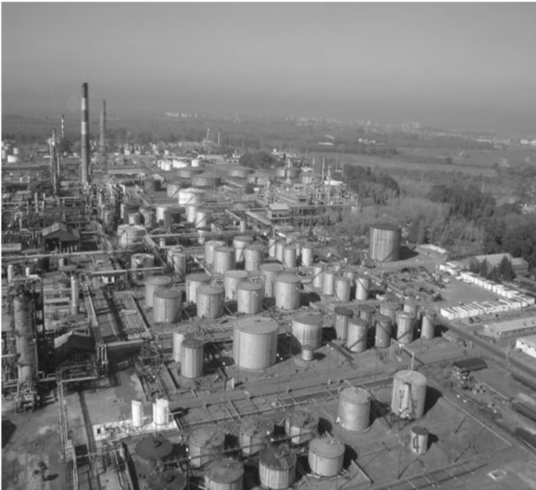
Imagen 4. Campo almacenamiento de solventes Shell Buenos Aires.
