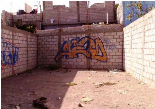
Propiedad en construcción en la Colonia Epigmenio González (El Oasis)
