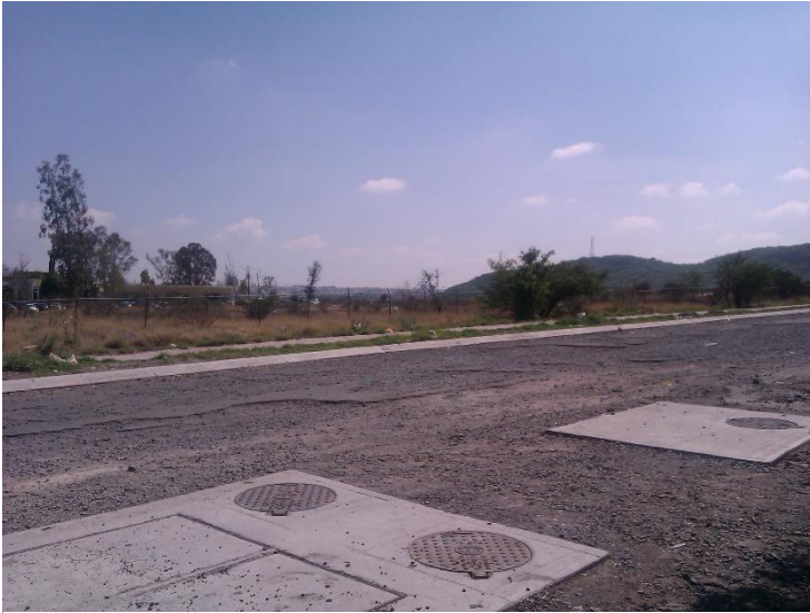
INFRAESTRUCTURA EN EL LUGAR (REGISTROS DE DESAGÜE) (CFE)
