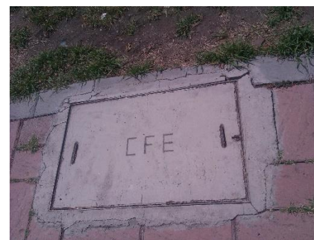
INFRAESTRUCTURA EN EL LUGAR (CFE)
