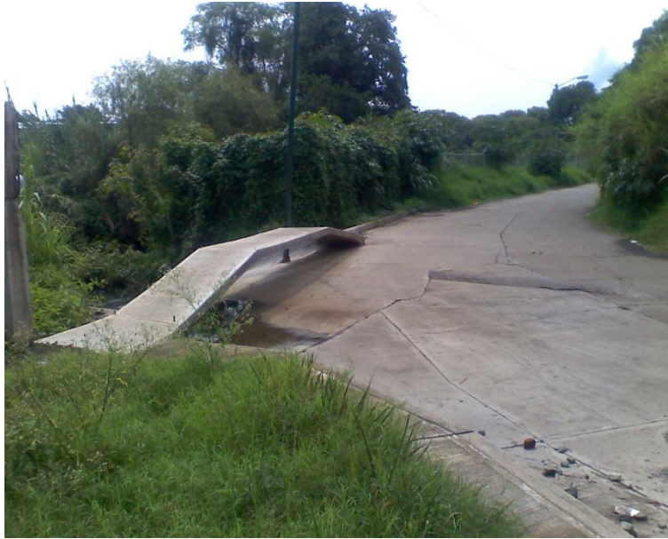
Imagen 3.8. Sitio donde se hará la conexión con Av. Latinoamericana.
