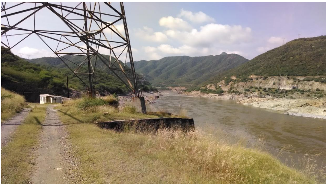
Imagen 4.10. Vista de la brecha que conduce hacia la estructura terminal, al costado cauce natural de descarga.
