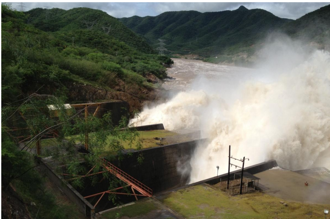
Imagen 3.7. Vista lateral de la cubeta deflectora en operación, efecto salto de esquí.
