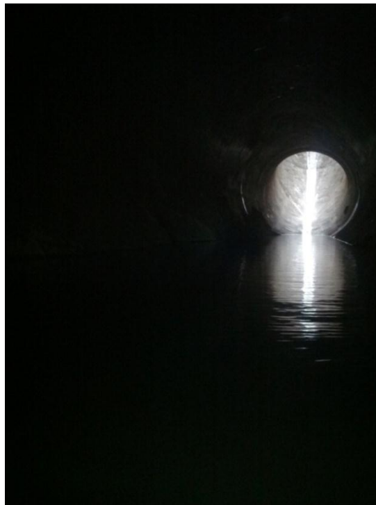
Imagen 6.1.6. Vista interna del codo del túnel vertedor.
