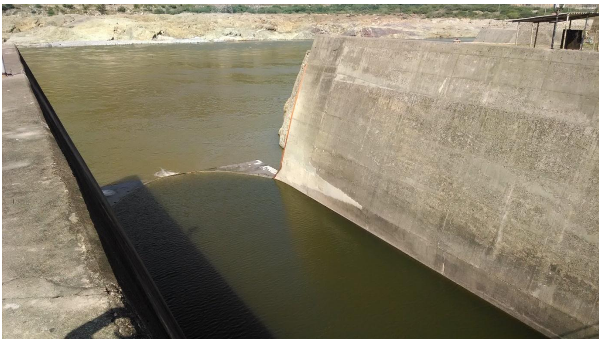
Imagen 3.4. Vista de la cubeta deflectora de la obra de excedencias.
