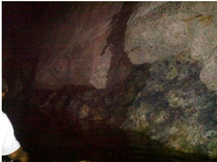
Imagen 6.4.2.3. Vista de la socavación profunda, dejando el terreno natural de roca expuesto.
