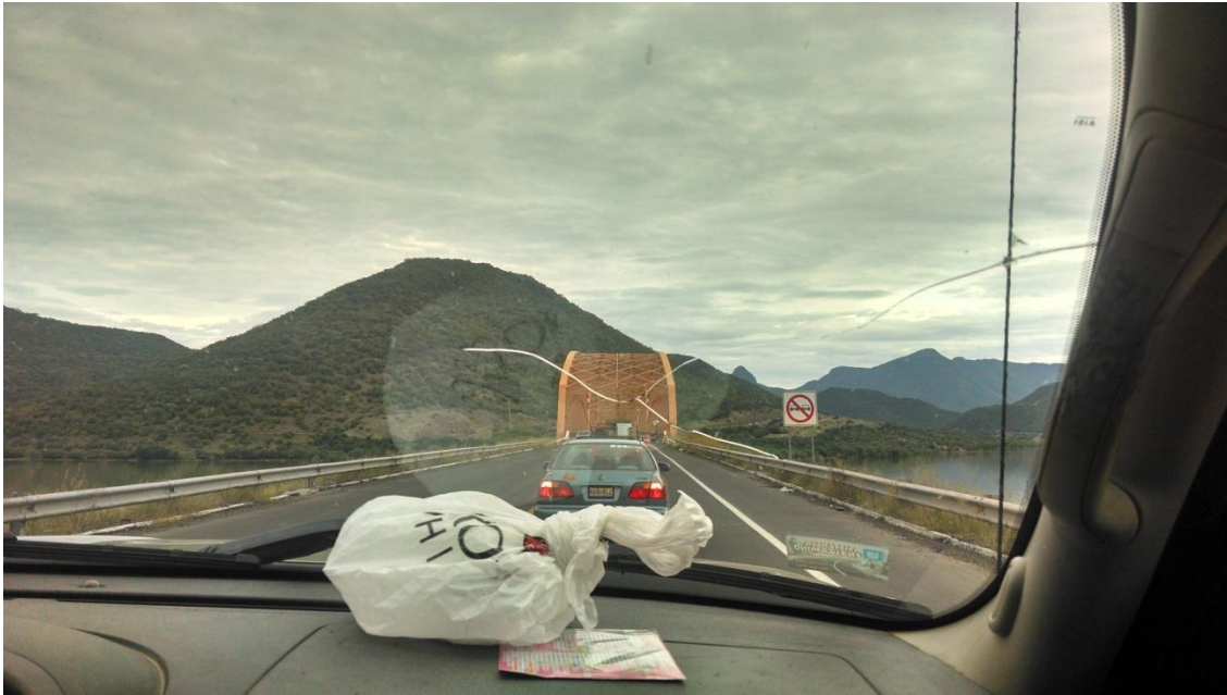
Imagen 4.3. Vista de una de las carreteras que cuenta con uno de los puentes mismos que conforman el sistema de vías terrestres.
