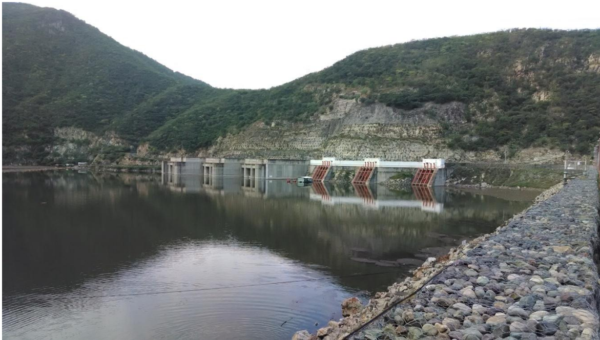
Imagen 6.1.1. Vista de la estructura de entrada de los vertedores (izquierda) y Obra de toma con rejillas naranjas (derecha).
