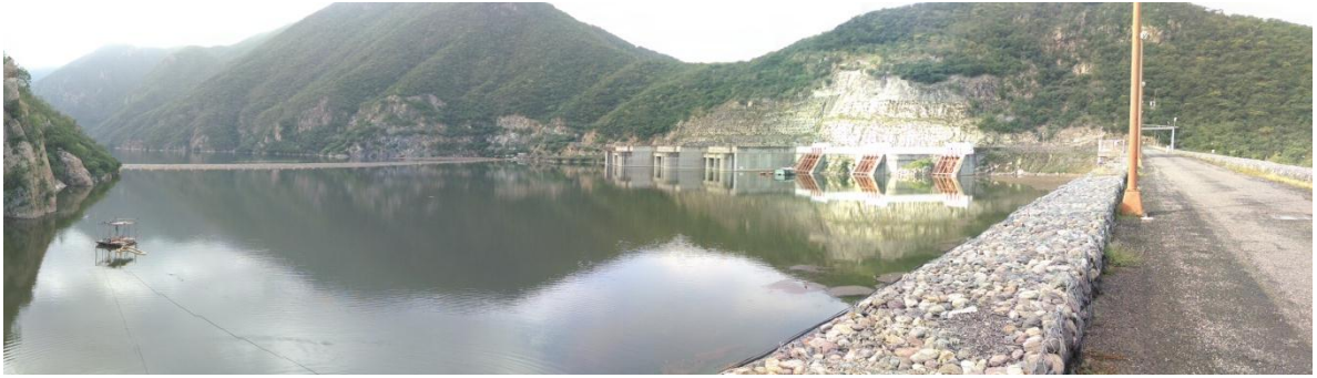
Imagen 4.9. Vista panorámica desde la corona de la cortina hacia el vaso, obra de excedencias y obra de toma de la presa de izquierda a derecha.
