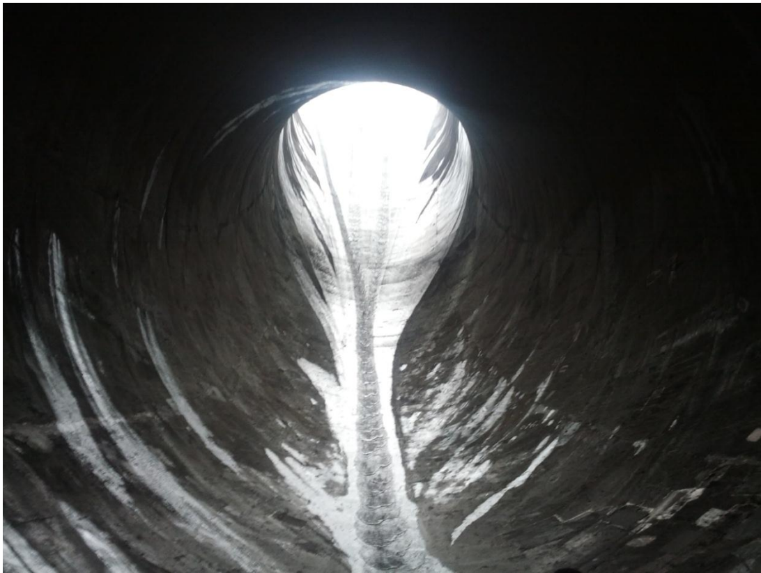
Imagen 6.1.4. Vista del interior del codo del túnel vertedor de concreto.
