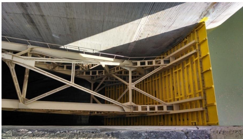
Imagen 6.3.1. Vista de la sección de la compuerta tipo abanico y su estructura metálica.
