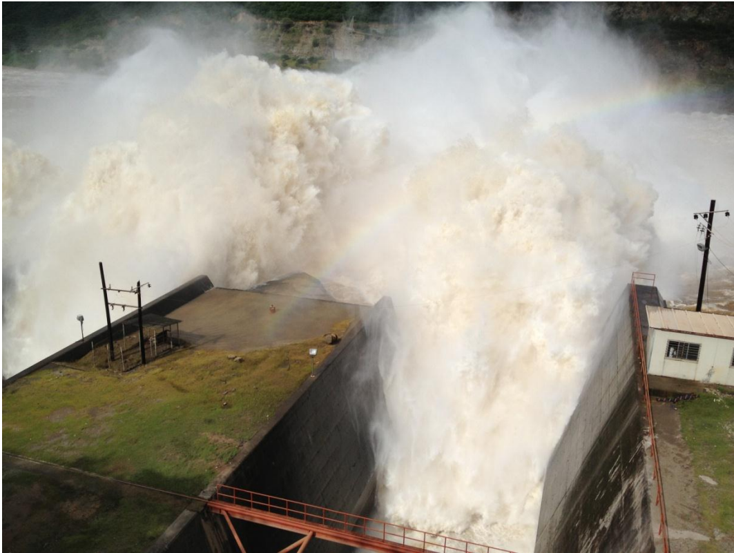
Imagen 3.6. Vista de la cubeta deflectora en operación, efecto salto de esquí.
