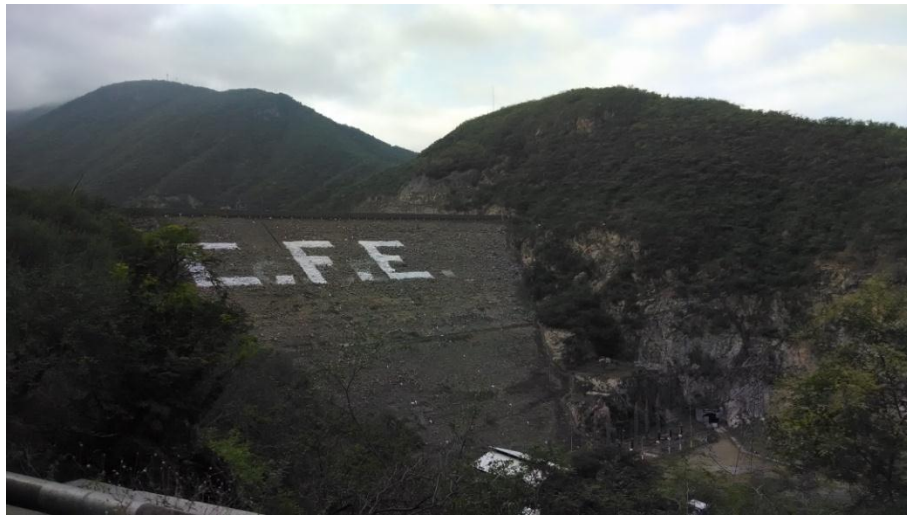
Imagen 4.8. Vista de la cortina de materiales graduados en la C.H. Infiernillo.
