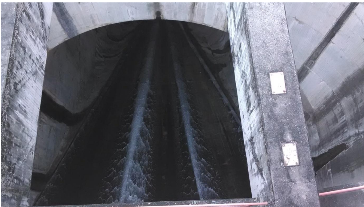
Imagen 3.3. Vista del canal de acceso de la obra de excedencias.
