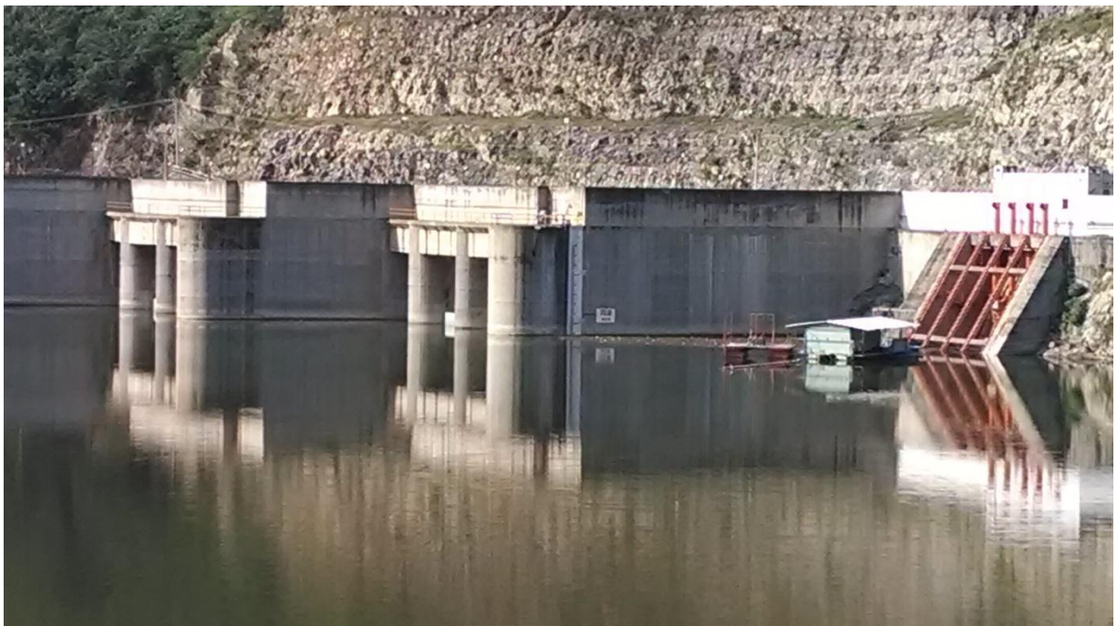
Imagen 3.2. Vista panorámica del sistema de obra de excedencias y a un costado la obra de toma.
