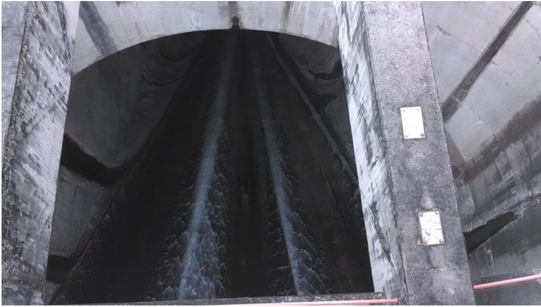
Imagen 6.4.1. Vista de la entrada al túnel vertedor.
