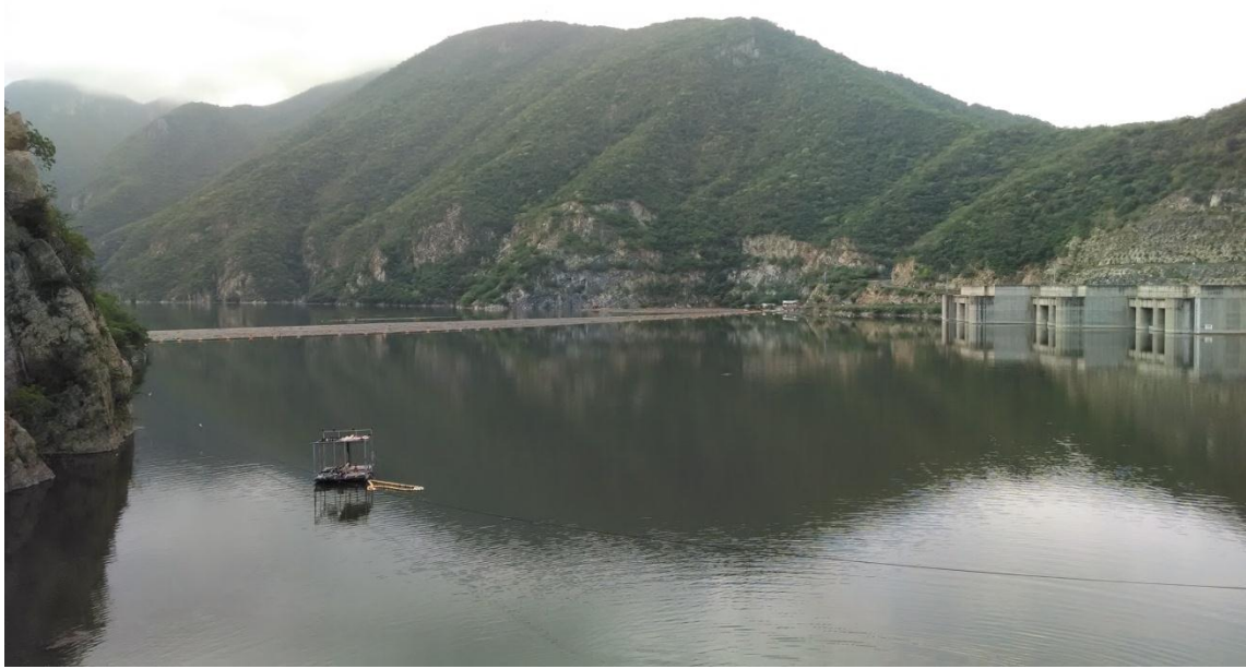
Imagen 3.1. Vista panorámica del vaso y el sistema de obra de excedencias a un costado.
