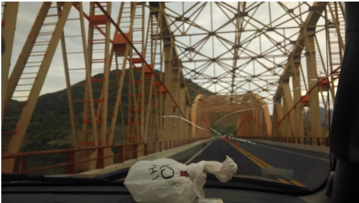
Imagen 4.4. Vista de la estructura metálica de un puente, tomada desde el interior del mismo.
