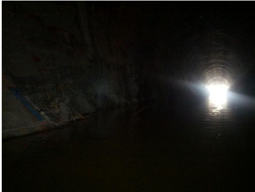
Imagen 6.1.5. Vista del túnel vertedor de concreto con daños por la última vez que se usó.
