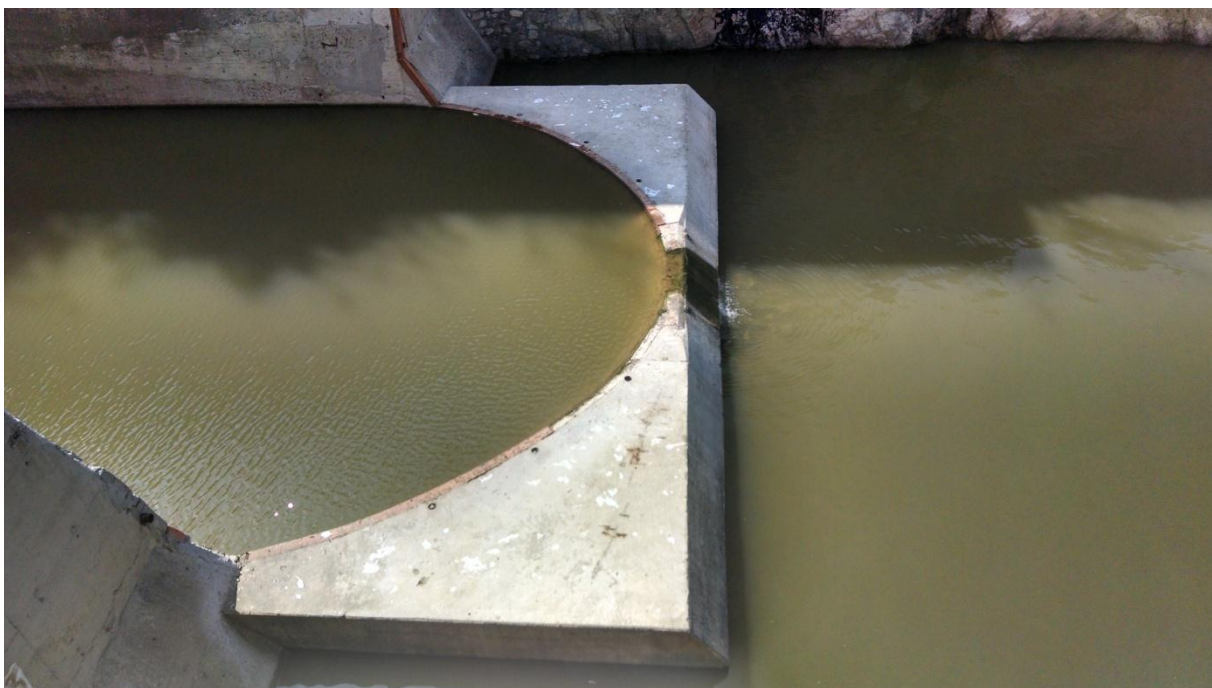
Imagen 3.5. Vista lateral de la cubeta deflectora de la obra de excedencias.
