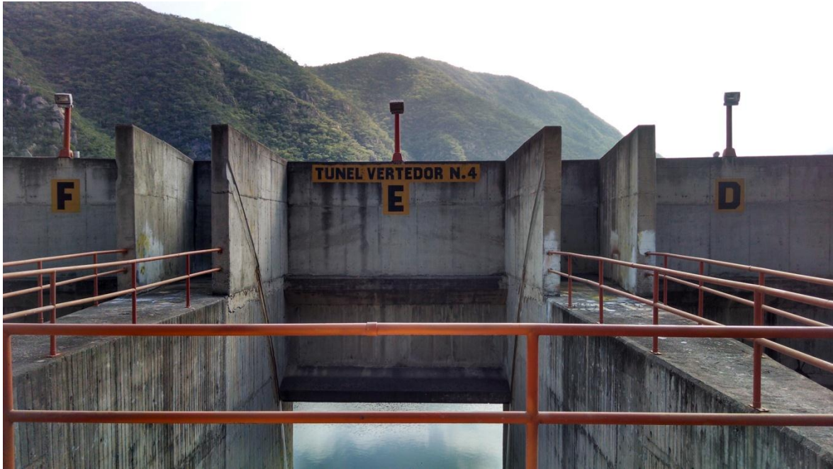
Imagen 6.1.3. Vista de las 3 secciones de las compuertas del vertedor No 4.
