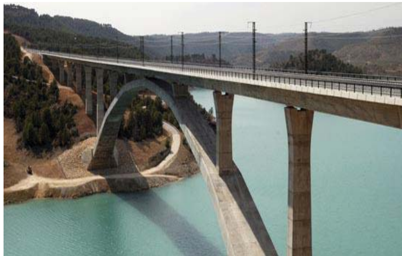
Fotografía.1.9. Viaducto de Contreras en la región Murcia, España.
