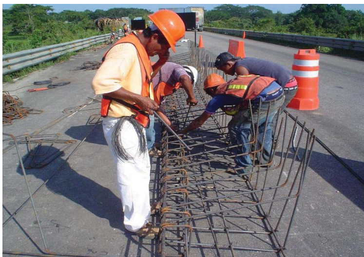
Fotografía 5.17. Armado de parapeto para la estructura PLAYAS I.
