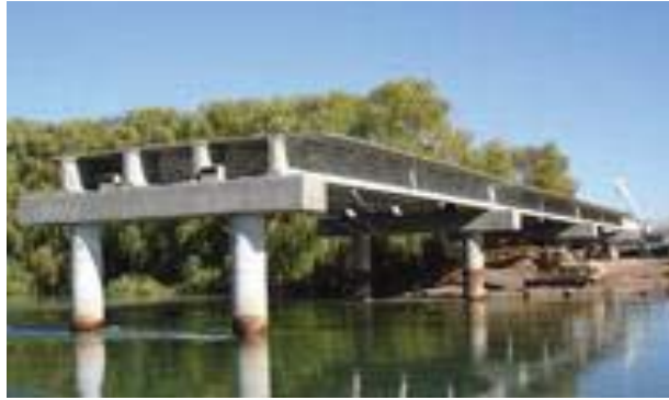
Fotografía.2.3. Ejemplo de Losa Tablero.
