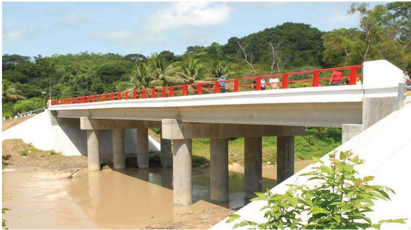
Fotografía.2.13. Puente Bicentenario en el municipio de Tihuatlán, Veracruz, México.
