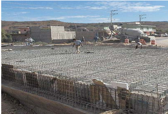
Fotografía. 2.1. Ejemplo de una losa reforzada.
