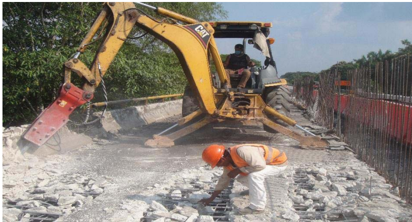
Fotografía 5.7. Demolición de losas con equipo neumático.
