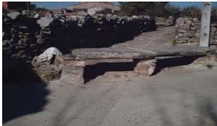
Fotografía. 1.2. Puente construido de losas de roca
