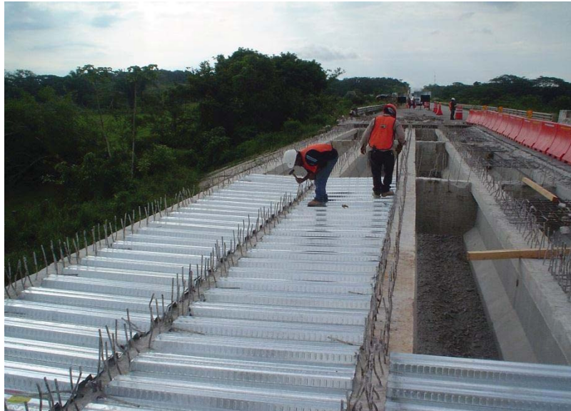
Fotografía 5.12. Colocación de tramos de losacero en espacios entre vigas de puente Playas I.
