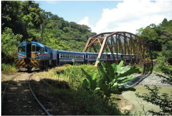
Fotografía.2.8. Puente Ferroviario sobre el Río Pacuare, Costa Rica.
