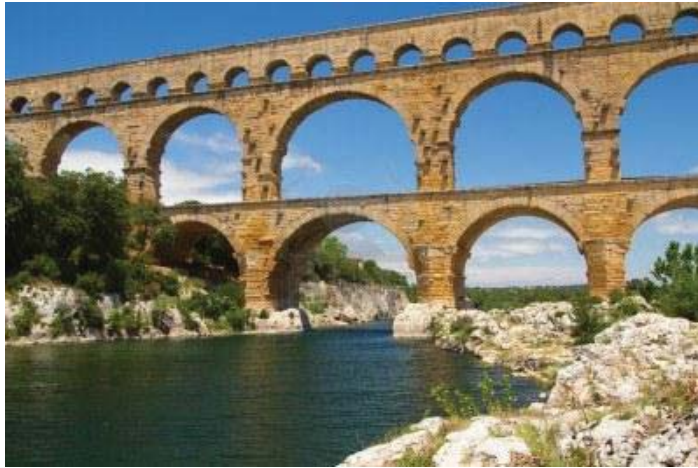
Fotografía.2.10. Puente-acueducto que cruza el Río Gardon, Francia.
