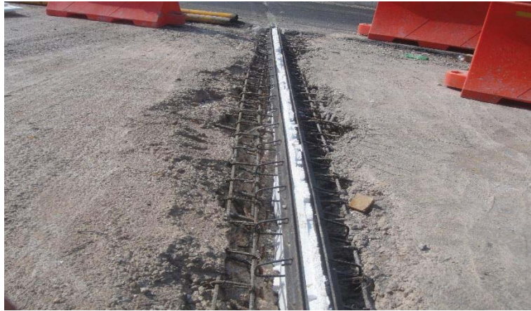
Fotografía 5.22. Colocado y alineado de estructura metálica de la junta.
