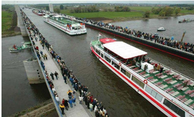
Fotografía. 2.9. Puente-canal sobre el Río Elbe, Alemania.
