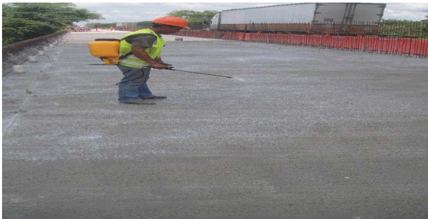
Fotografía 5.21. Imagen que muestra la forma de curar elementos colados con Curacreto.
