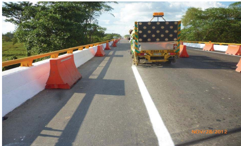
Fotografía 5.31. Suministro de pintura en Líneas Continuas Laterales, tramo Playas II.
