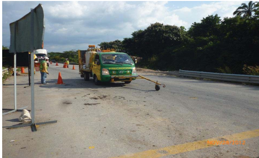
Fotografía 5.29. Alineación del Vehículo con Equipo para Señalización o Pinta Rayas en tramo de Playas II.
