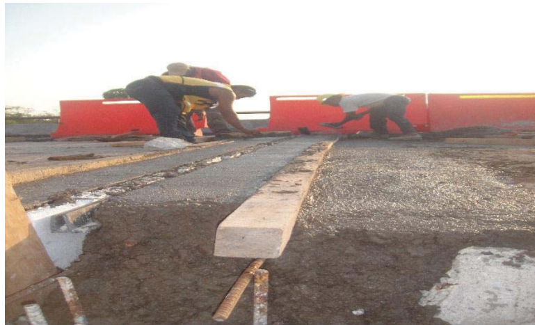
Fotografía 5.23. Colado de área limitante a la junta de dilatación.
