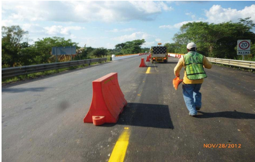
Fotografía 5.30. Suministro de pintura en Línea Punteada en Playas II.
