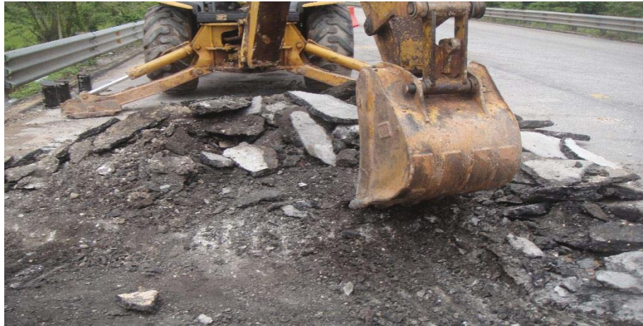
Fotografía 5.5. Corte de carpeta asfáltica dañada, por medio de retroexcavadoras.
