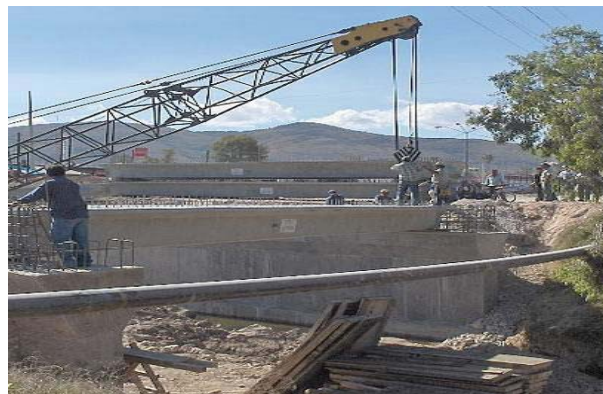
Fotografía. 2.2. Alineamiento y colocación de viga preesforzada de concreto en puente.
