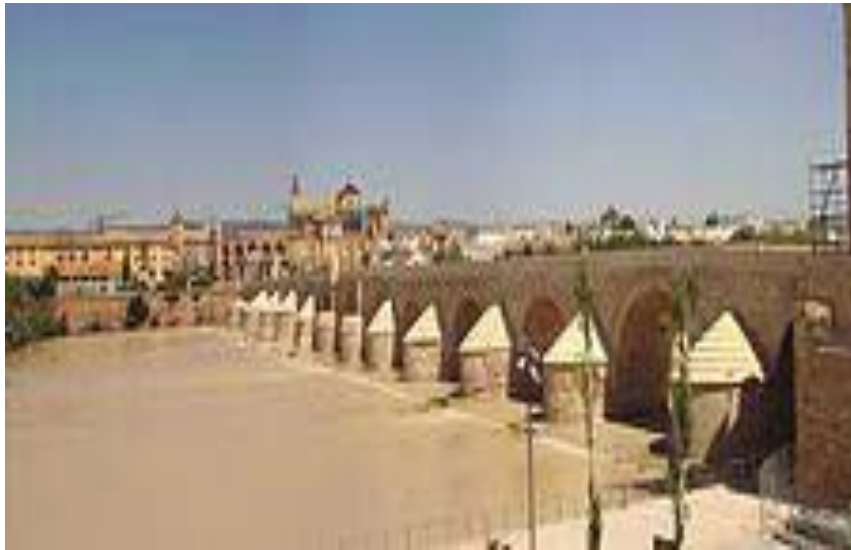
Fotografía. 1.3. Puente Romano de Córdoba construido en el siglo I a.C.
