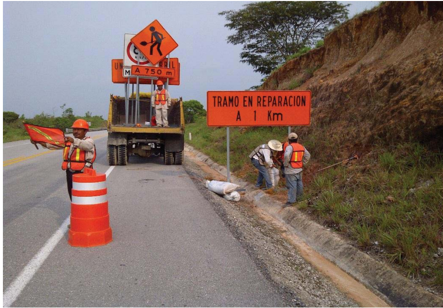
Fotografía 5.2. Brigada instalando el señalamiento en obra.
