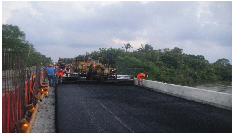
Fotografía 5.27. Tendido de carpeta asfáltica con equipo Finisher o extendedora de asfalto con los niveles deseados (PLAYAS II).
