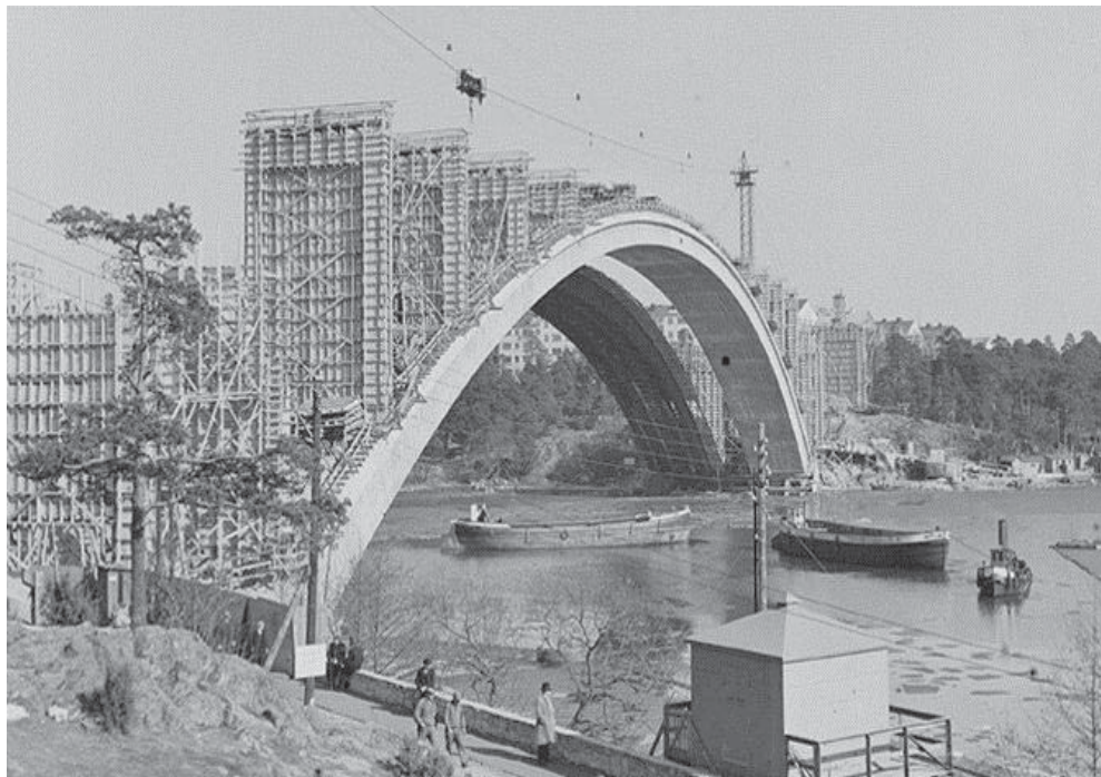
Fotografía. 1.6. Construcción de puente Tranebergsbron, Estocolmo, Suecia en 1933.
