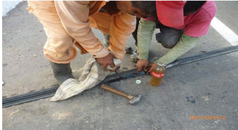
Fotografía 5.24. Colocación de Junta de Neopreno utilizando lubricante y equipo adecuado.
