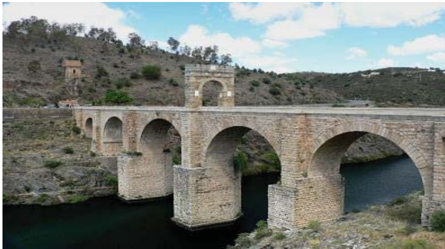
Fotografía. 1.7. Puente de Alcántara en el Río Tajo, Portugal.
