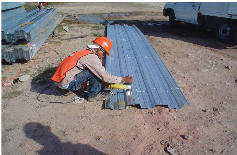
Fotografía 5.11. Marcado y corte de tramos en lamina de losacero, en almacén para su posterior traslado a obra.
