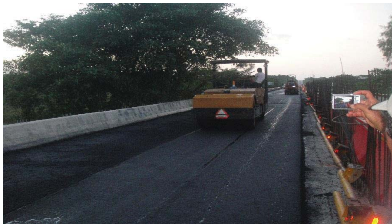
Fotografía 5.28. Compactación de la carpeta con rodillos liso y neumático en Playas II.
