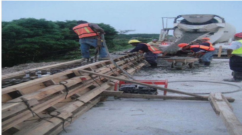
Fotografía 5.20. Imagen que muestra el equipo y el vibrado que se emplea al momento de colar los elementos en estructura PLAYAS I.
