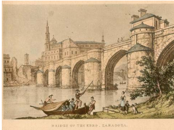
Imagen.1.2. Puente Piedra en Zaragoza, España.
