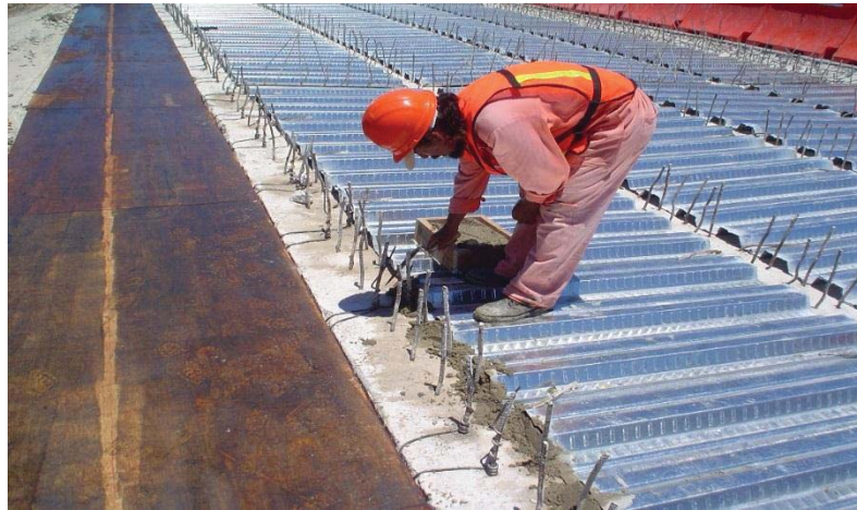
Fotografía 5.14. Relleno de espacios con mezcla de mortero Grout.
