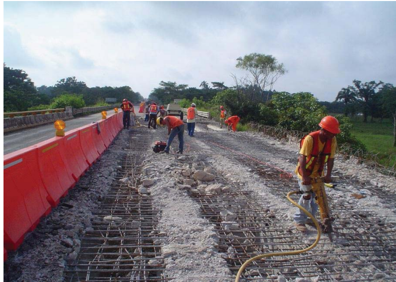
Fotografía 5.10. Demolición de losa de concreto y retiro de acero expuesto.
