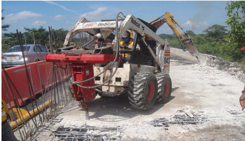
Fotografía 5.8. Demolición de concreto ubicado sobre las vigas con equipo más ligero para evitar fracturas.
