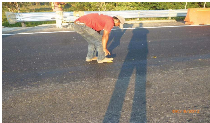
Fotografía 5.32. Colocación de Vialitas ámbar en Playas I.
