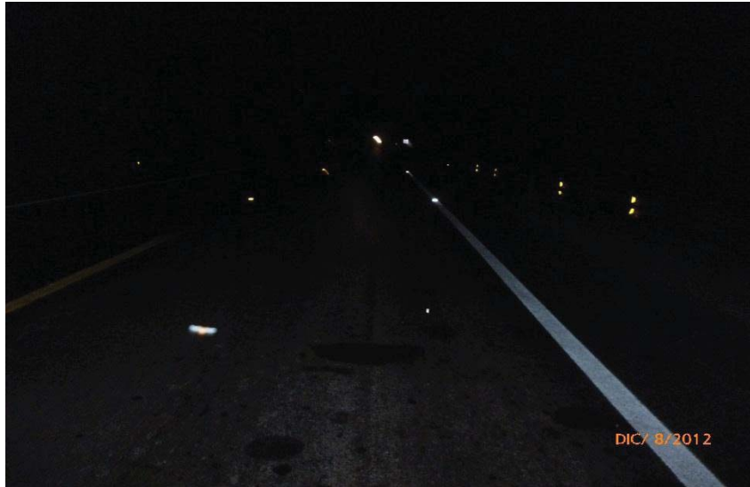
Fotografía 5.34. Vista nocturna del efecto reflejante de las Vialitas y Líneas continuas y punteadas en tramos de Puente Playas II.
