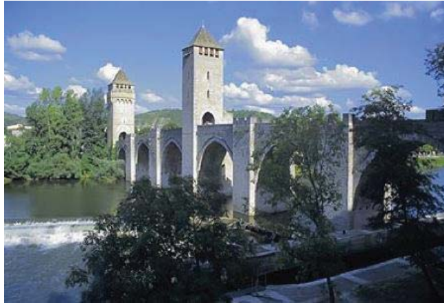
Fotografía.1.4. Puente Laroque-des-Arcs ubicado en Arcambal, Francia.
