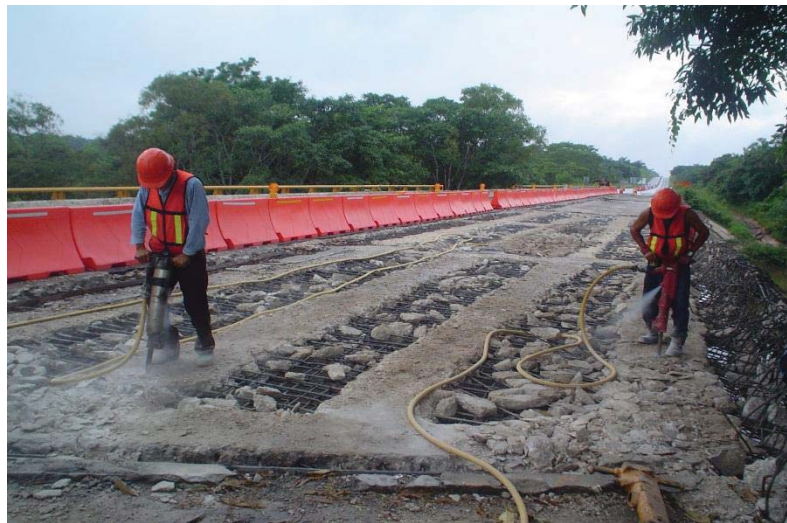
Fotografía 5.9. Demolición de concreto en áreas muy específicas con roto martillo.
