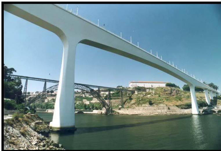
Figura 2.13 Puente pórtico Sao Joao, Portugal
