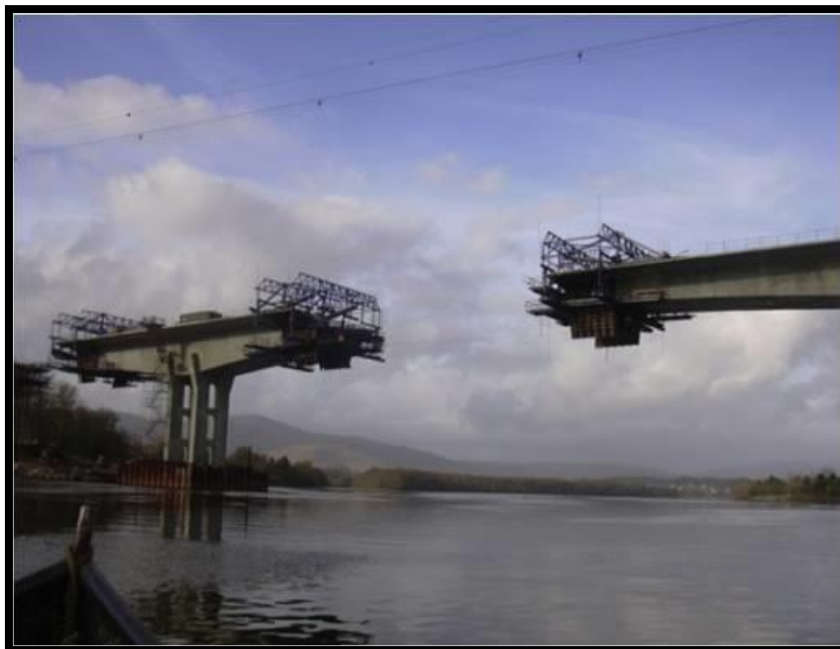
Figura 2.21 Ejemplo de puentes construidos en volados sucesivos
