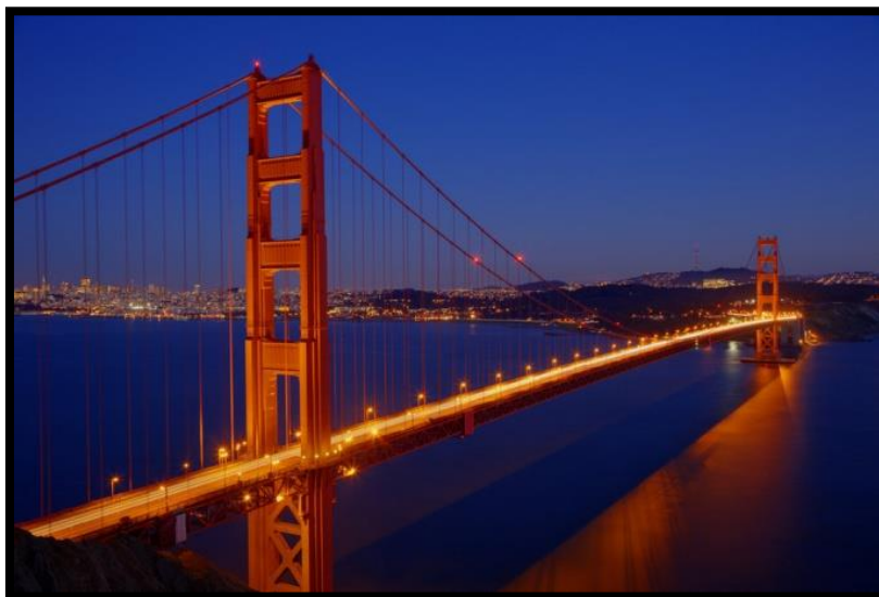
Figura 2.11 Puente colgante de acero Golden Gate sobre bahía de San Francisco, EEUU
