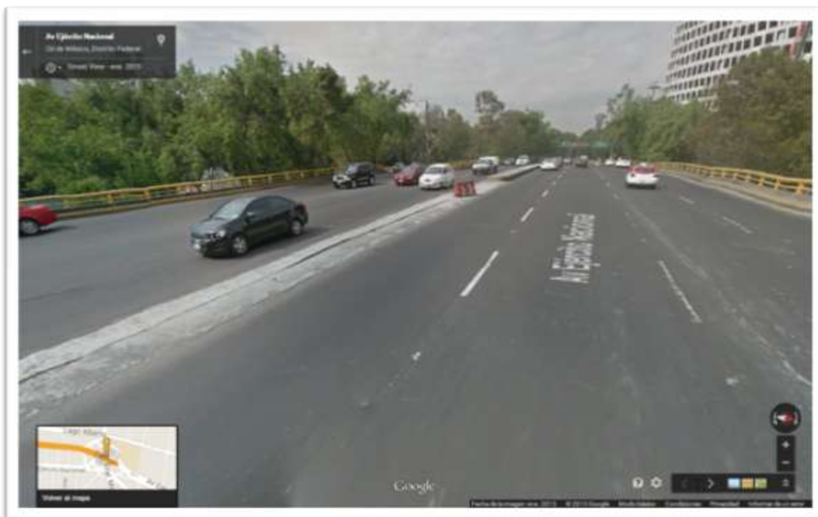
Imagen 8. Imagen Google 2015. Sección que se usa para carriles reversibles en la intersección de Avenida Río San Joaquín con la Avenida Ejército Nacional.
