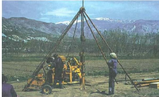
Figura 3.18 Ensayo SPT. ( www.aconstructoras.com ).
