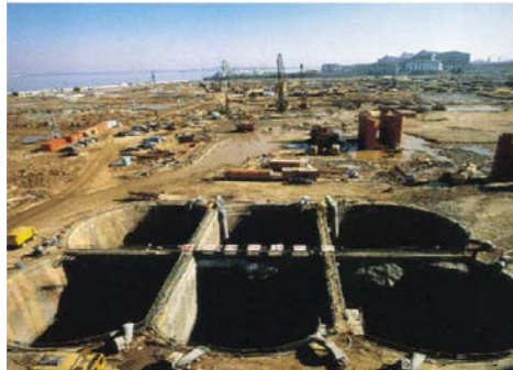
Figura 4.8 Lumbreras con muro Milán estructural (Paulin, 2010).
