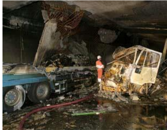
Figura 5.6 Elementos de la infraestructura del túnel de san Gotardo después del incendio de 2001 (Diario “El País”).
