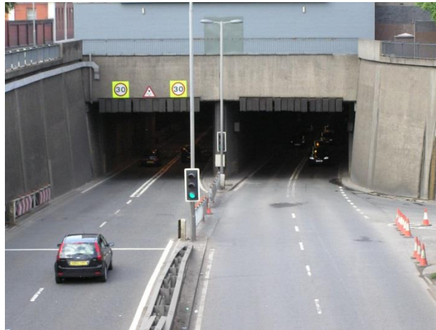
Figura 1.4 Túnel Clyde, Escocia.
