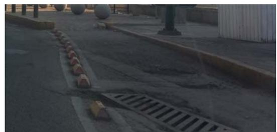
Figura 45. Ciclo vía en mal estado, deficiente pavimento y encharcamiento. Fuente: La autora.
