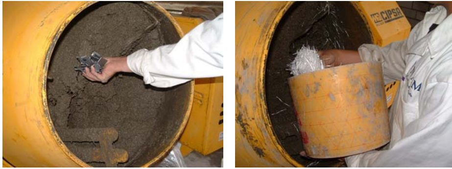
Figura 2.7 Adición de fibras a la revolvedora
