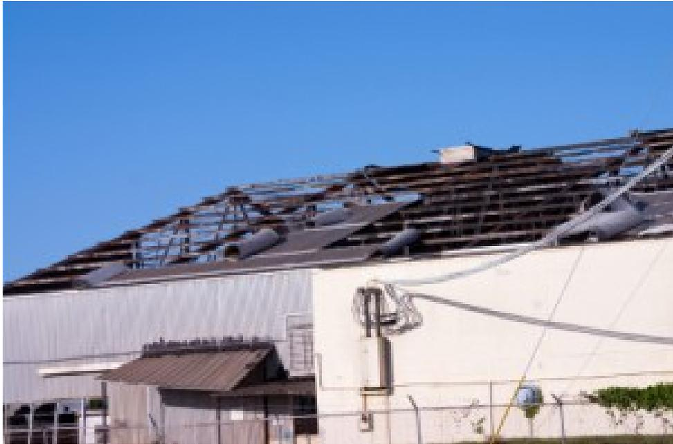
(a) Daño en edificio con sistema de techo a dos aguas
