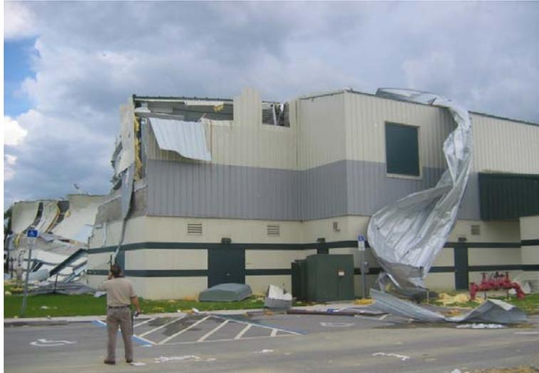
Figura 2.6: daños a edificios debidas a vientos extremos.
