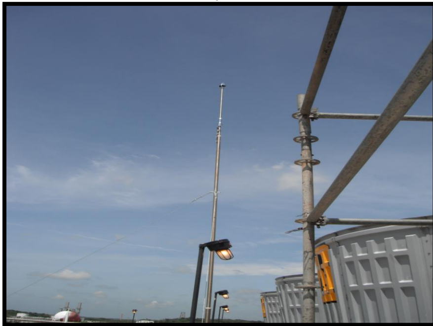
FIGURA 33. Instalación de Sistema Pararrayos.
