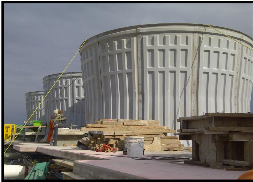
FIGURA 26. Instalación y Colocación de Venturi
