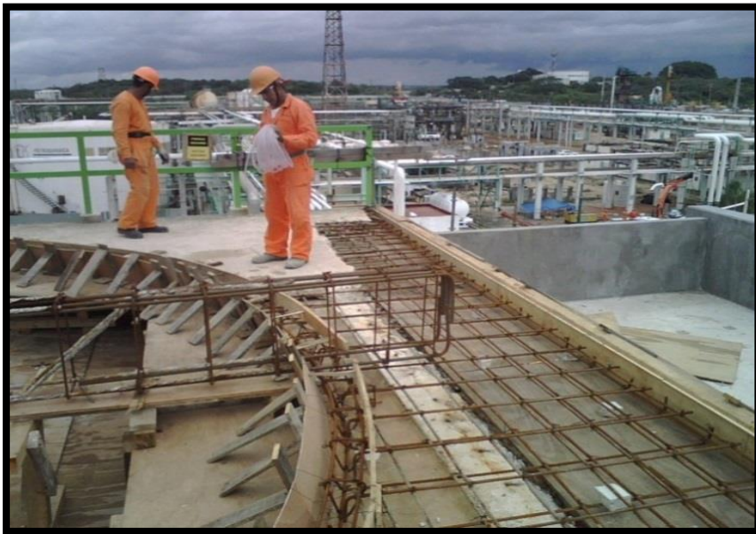
FIGURA 19. Demolición y Construcción de Marquesina y de Base para Venturi de proyecto
