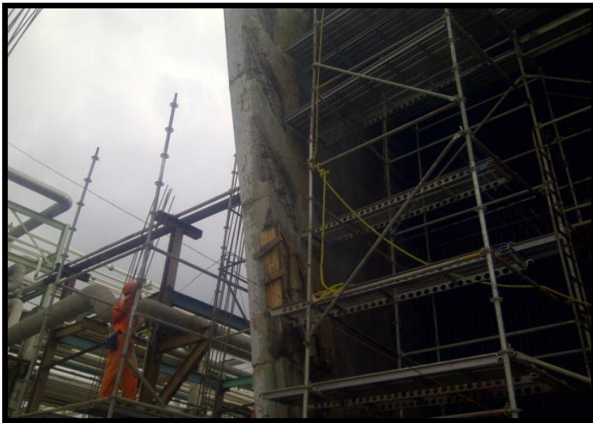
FIGURA 17. Colado de las Aberturas Existentes
