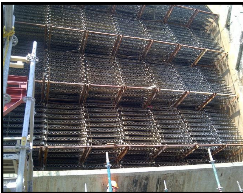
FIGURA 3. Internos o Surtidor por Salpicadura de Flujo Cruzado.
