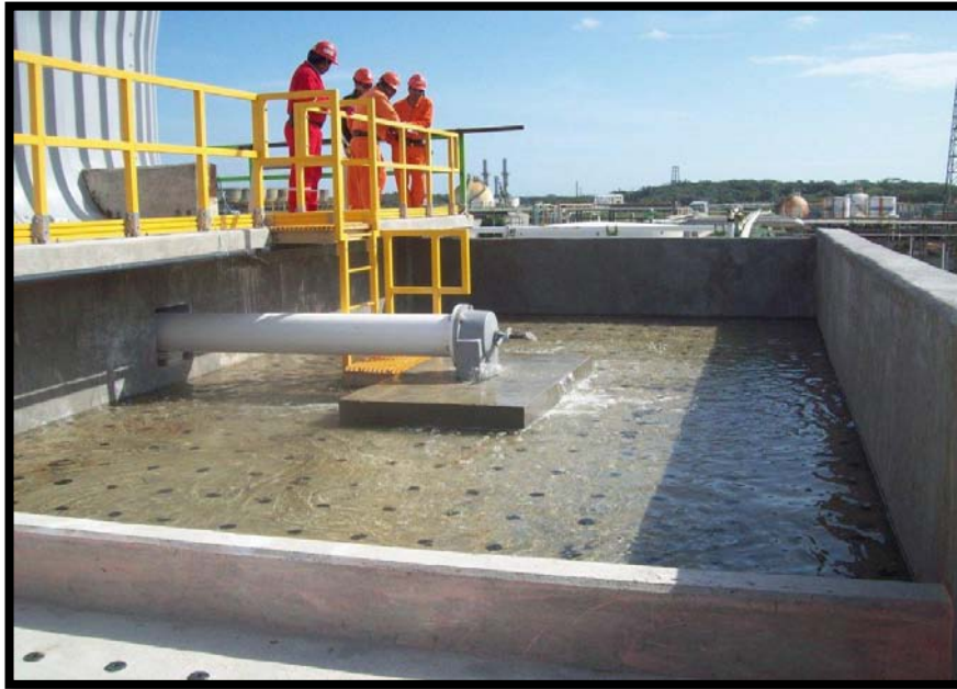
FIGURA 28. Instalación de Barandales de Fibra de Vidrio
