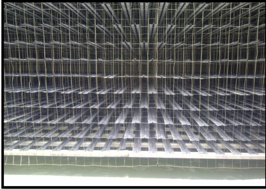
FIGURA 23. Suministro e Instalación de Relleno de Salpiqueo
