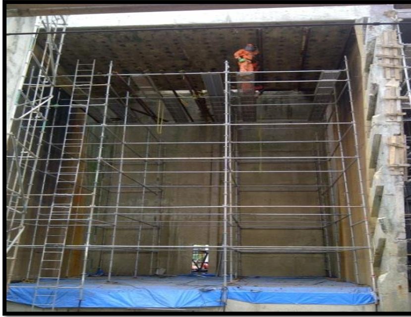
FIGURA 9. Instalación de Andamio y Colocación de Tarima para Retiro de Material.
