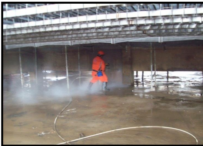
FIGURA 13. Limpieza con Hidrolavadora en Bacín de Agua Fría.
