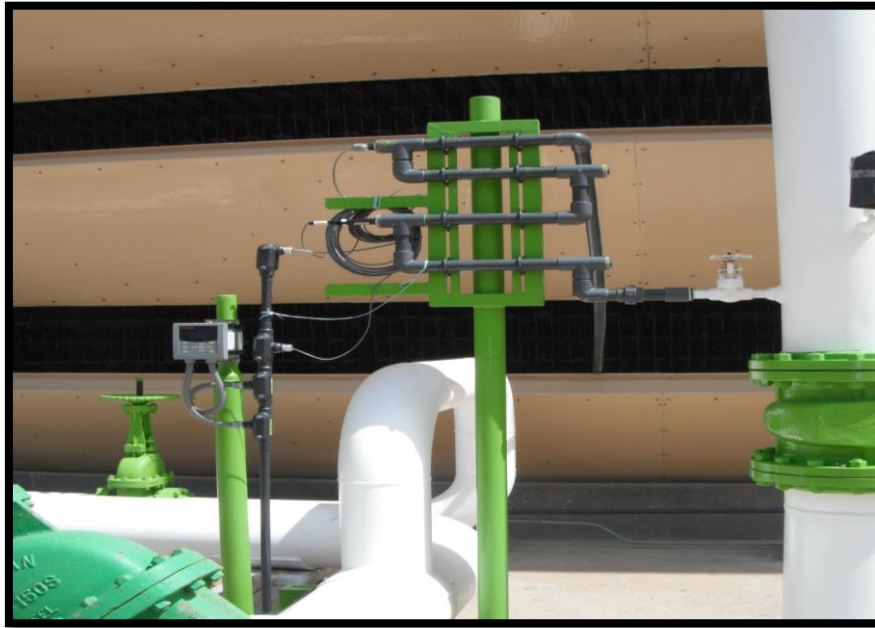
FIGURA 32. Instalación de Testigos de Corrosión
