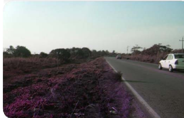
CARRETERA COATZACOALCOS- MINATITLÁN
