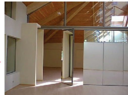
Incorporación de un sistema de paneles acústicos corredizos
