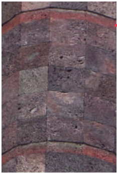
Piedra tezontle utilizada en fachada
