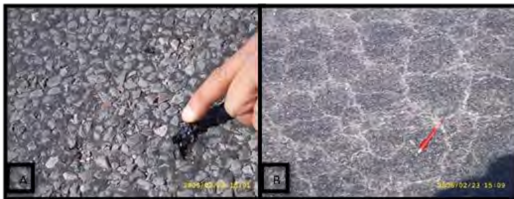
Figura 3.4 Comparativa de asfalto ahulado (A) con el asfalto convencional (B) [15].
