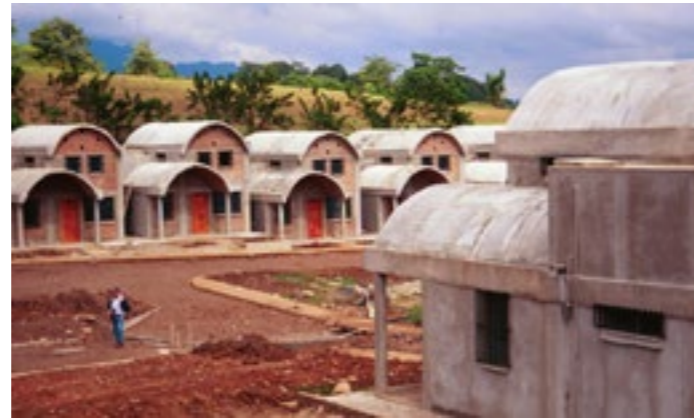
Imagen 73.- Conjunto de viviendas para personas con escasos recursos en La Dalia, Nicaragua. Arq. Carlos González Lobo (2003).
