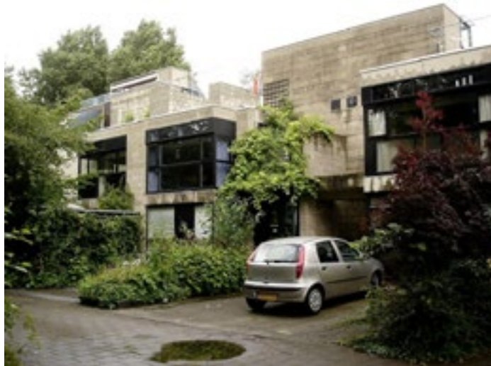
Imagen 42.- Dos de las casas del Diagoon Housing del arquitecto Herman Hertzberger (Delft, Holanda, 1967-71).
