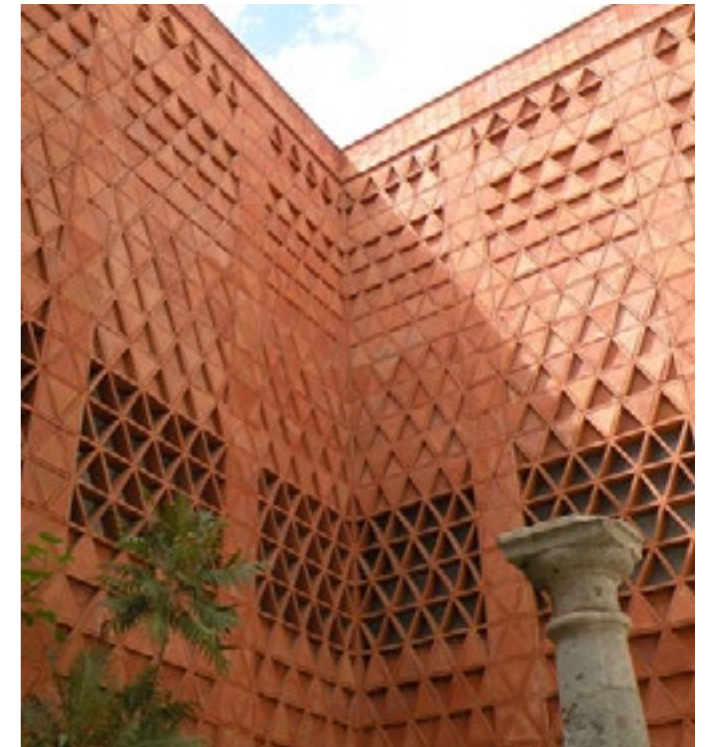
Imagen 59.- Detalle del muro en el Patio del Museo textil de Oaxaca (2007). Arq. Juan José Santibañez
