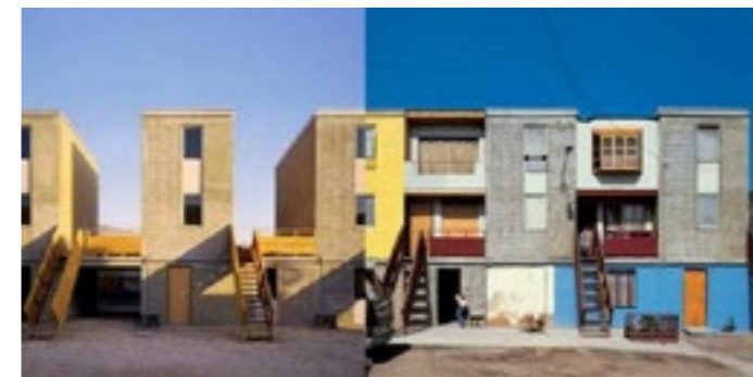
Imagen 65.- Viviendas en Quinta Monroy, las cuales han sufrido modificaciones por parte de sus habitantes con el paso del tiempo.
