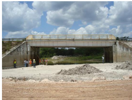
Construcción de estructuras de obra mayor (puente)
