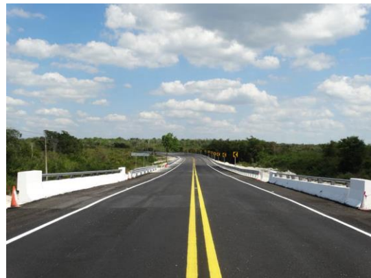
Después de la modernización, tenemos una carretera tipo A2.
