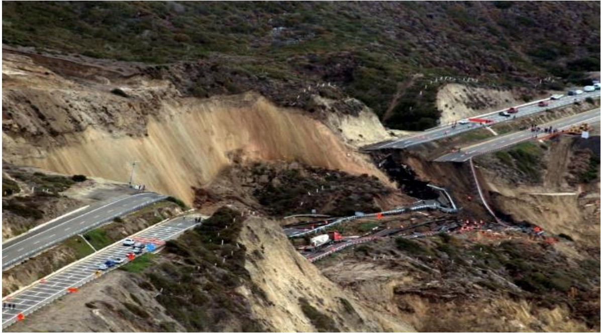
Fig. 1-2 Afectaciones a la Carretera Escénicas con el deslizamiento del 28 de diciembre de 2013 (Pedraza, 2013)
