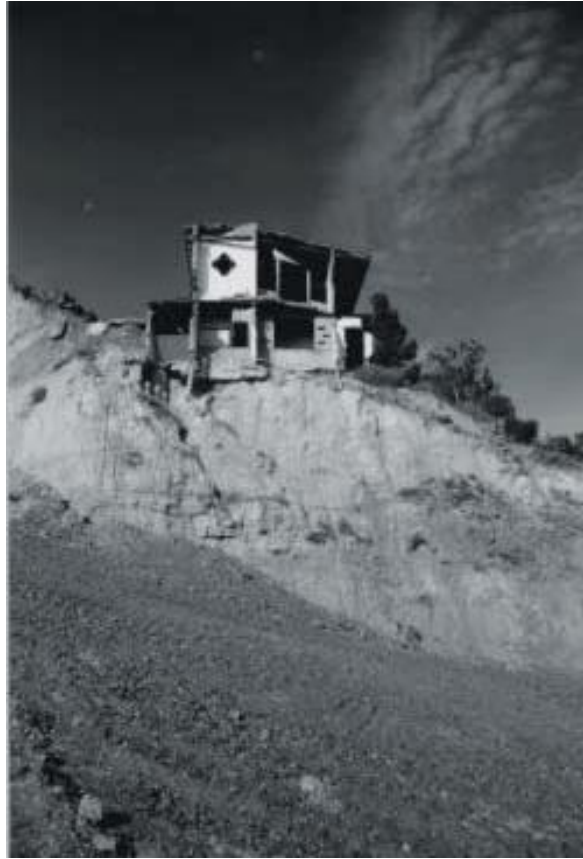
Fig. 1-1 Casa afectada por deslizamientos de 1976 (Manuel Cruz-Castillo, 2000)
