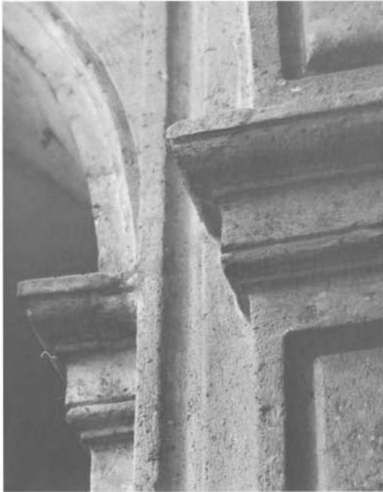
19. Impostas de los arcos del corredor del patio central
