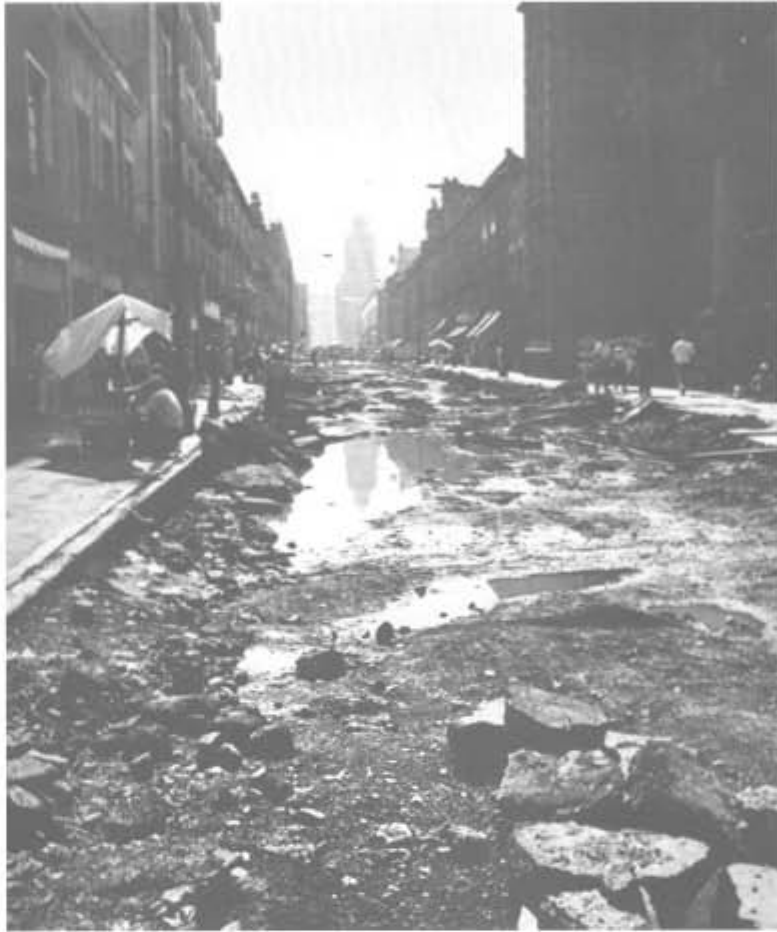
25. Calle de moneda durante las obras de restauración del centro histórico de la ciudad de México
