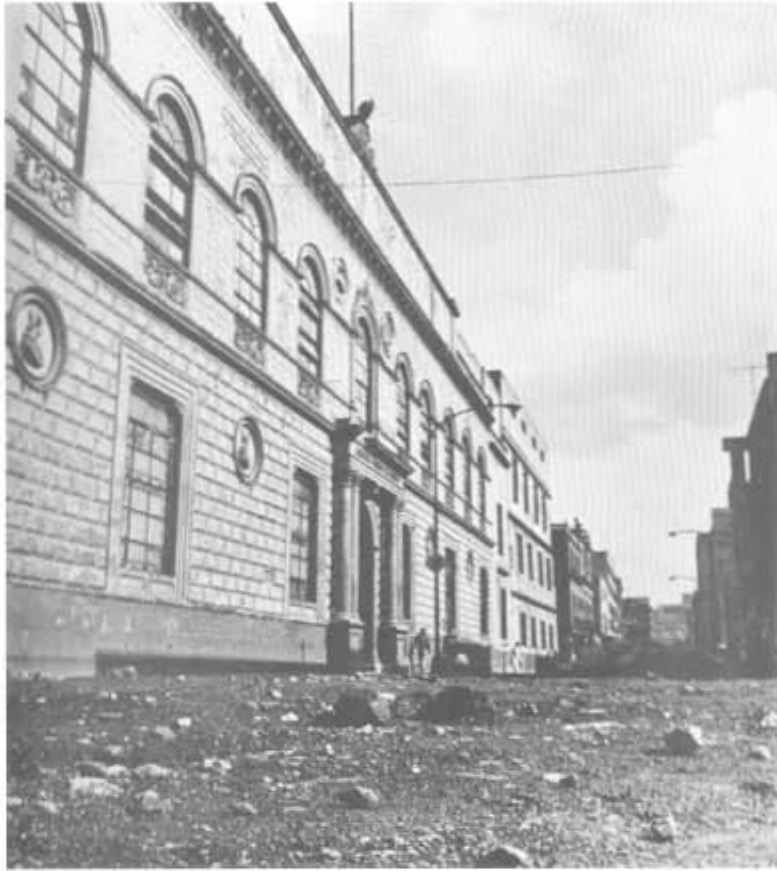
26. Calle y fachada de la academia durante las citadas obras de remodelación
