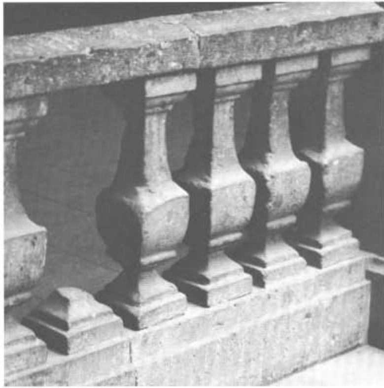
9. Balastrada circundante al patio central. Planta alta
