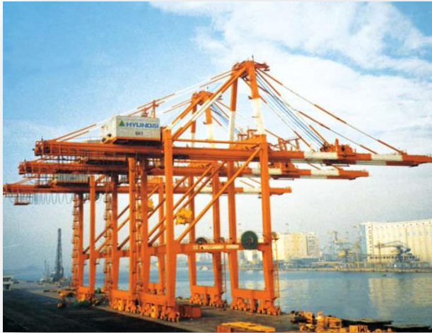
Grúa Pórtico (quay cranes).
