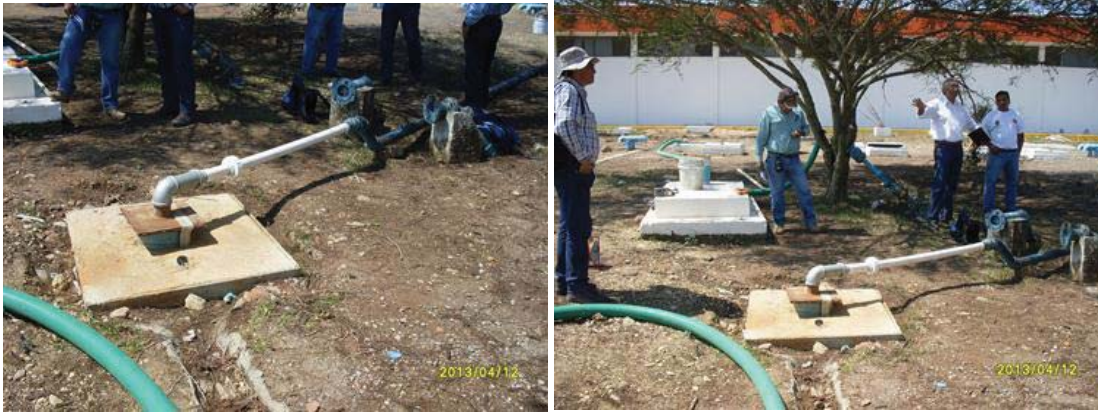
Figs. A.11. Pozo Escuela Nacional de Protección Civil.
