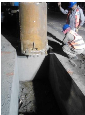
Figuras 64 y 65 .Perforación y Verticalidad. Pilas Oblongas
