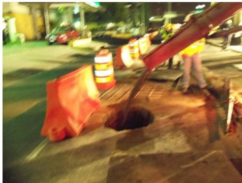
Figura 44. Vertido de relleno fluido. Pilas en Arenas
