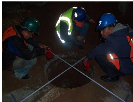
Figura 11. Medición del desplome de la perforación.
