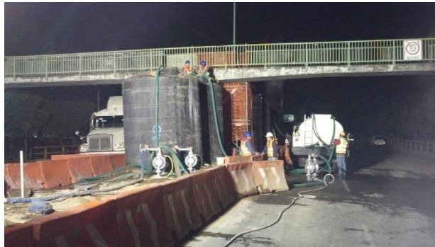
Figura 63 .Cisternas de Fluidos estabilizadores (Polimero). Pilas Oblongas
