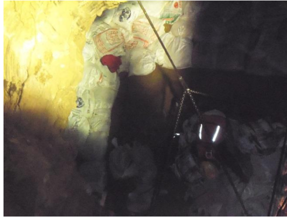
Figura 76. Debe quedar confinado al tope.. Pilas en Zona Minada
