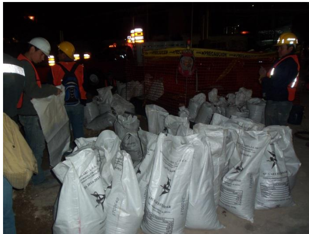
Figura 74. Colocación de confinamiento (Costalera). Pilas en Zona Minada
