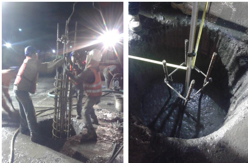
Figuras. 15 y 16 Colado de pilas, colocación del accesorio de acero de refuerzo de conexión pila zapata-columna.
