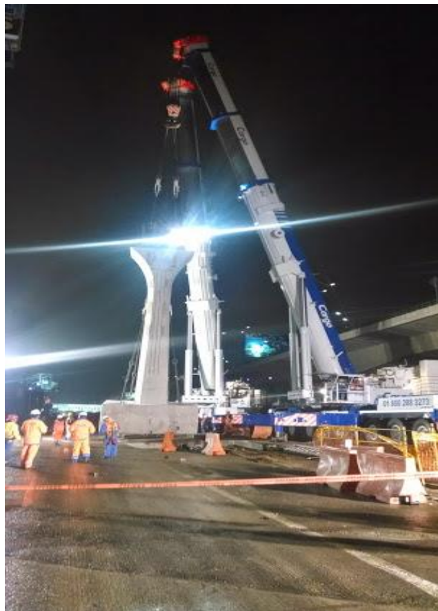
Figura 24. Montaje de Zapata-Columna
