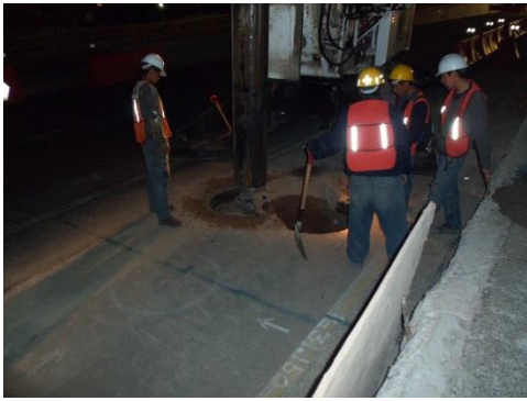
Figura 72. Perforación de galería de acceso. Pilas en Zona Minada
