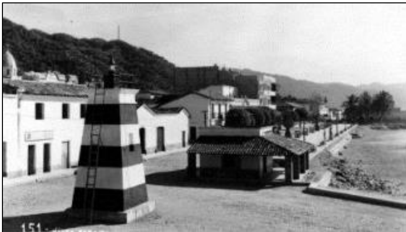
Imagen 7. Vista del malecón antes de la ampliación
