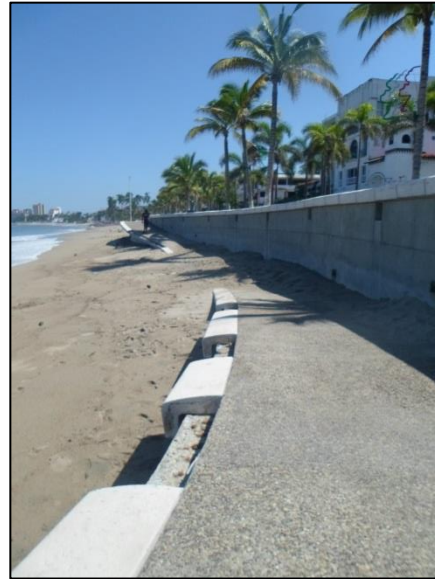
Imagen 29 y 30. Deterioro y falta de mantenimiento del malecón
