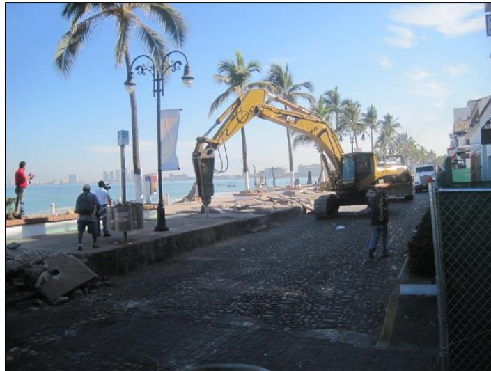
Imagen 24. Inicio de trabajos de renovación del malecón
