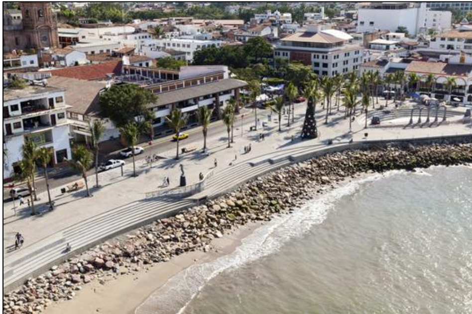
Imagen 23. Vista del tramo de malecón colindante con calle Morelos
