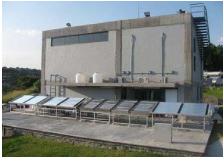
Figure 1.9: Instalaciones de investigación del LACYQS. Planta Solar para el Tratamiento Fotocatalítico de Aguas Residuales (PSTFAR).
