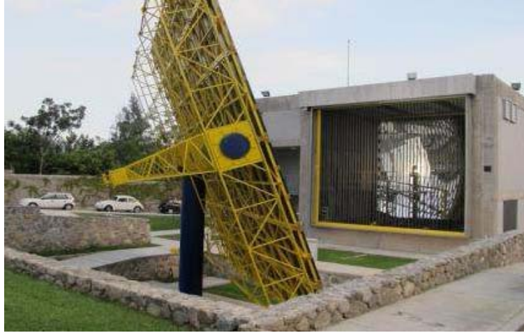
Figure 1.8: Instalaciones de investigación del LACYQS. Horno Solar de Alto Flujo Radiativo (HoSIER).
