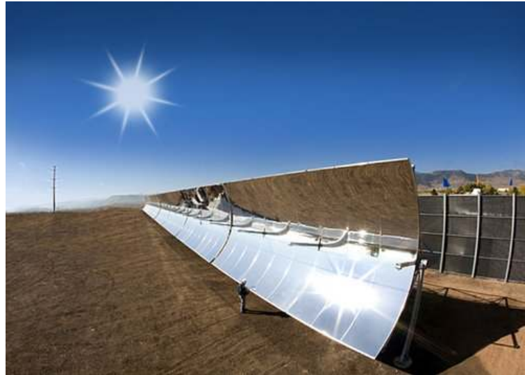
Figure 1.5: Sistema de Canal Parabólico instalado para minería en Atacama, Chile.
