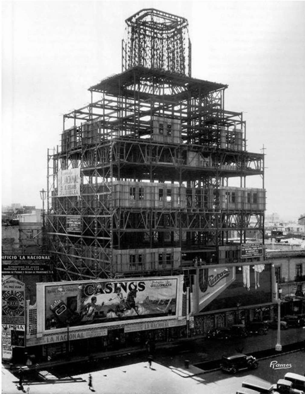
Figura 2.15. Estructura del edificio La Nacional, en construcción cerca de 1931.
