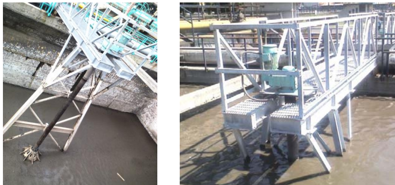
Figura 1.13 Bioselector anóxico (Unidad III).
