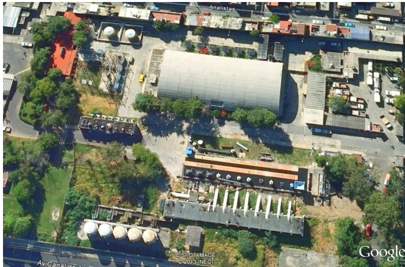
Figura 1.6 Vista aérea de la Estación de Bombeo de San José Aculco. Tomado de Google Earth, 2014.
