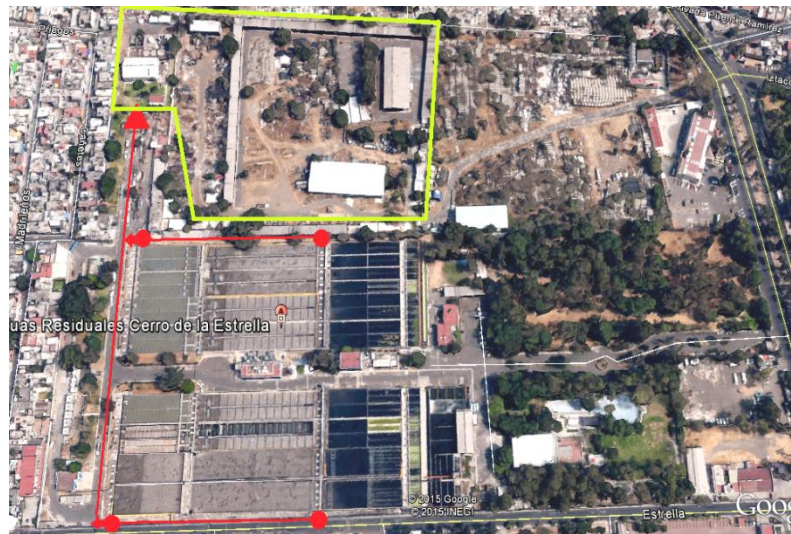
Figura 3.2 Vista aérea de la Planta de Tratamiento de Aguas Residuales “Cerro de la Estrella”. Tomado de Google Earth, 2014.
