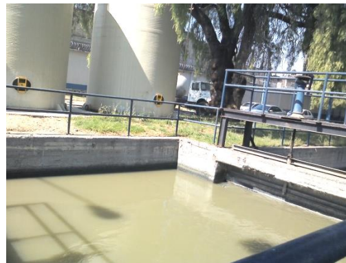
Figura 1.7 Caja de llegada del influente.
