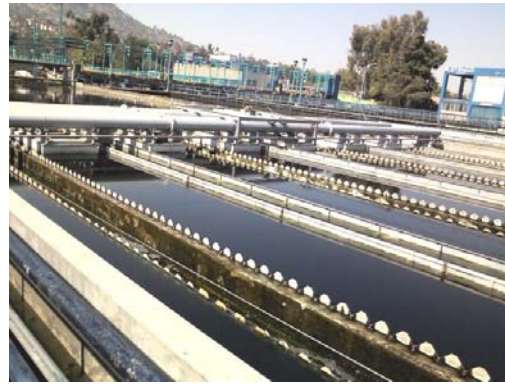
Figura 1.26 Sistema clariback en el sedimentador secundario de la Unidad IV.
