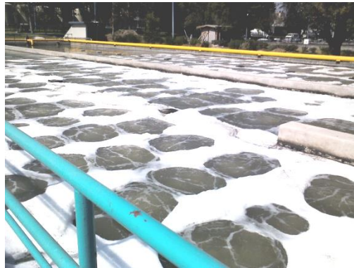
Figura 1.18 Tanque de aireación con presencia de espuma (Unidad III).
