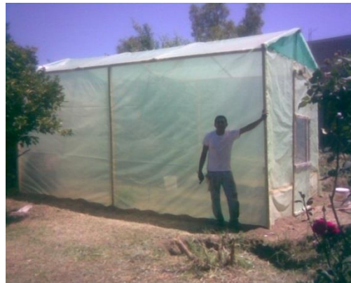
Figura 14. Instalación del invernadero.
