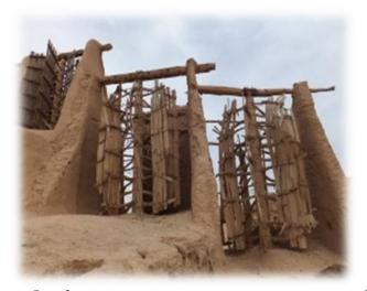
Figura 2. Molino de viento persa. Fuente: www.renewableenergyworld.com
