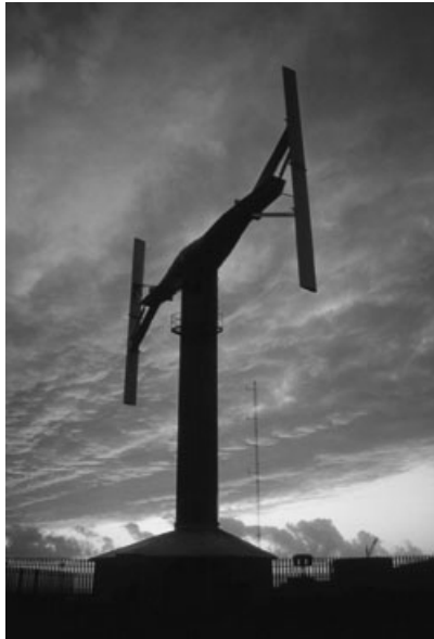
Figura 1.10: Aerogenerador VAWT-450 construido en Gales en 1986. Tenía un área de barrido 450 m. Fue desmantelado en el año 2000. http://bit.ly/1cLXc3H
