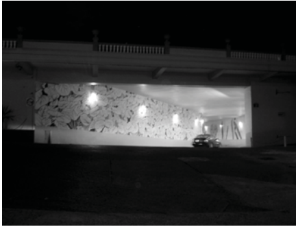
Fig. 16 Viaducto decoración, foto digital colección del autor
