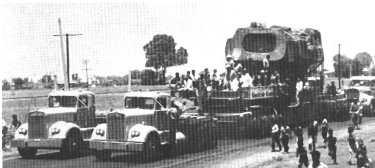
Fig. 108, 109. Para trasladarlo se diseñó un remolque especial doble con más de 20 ejes, jalado por dos tractocamiones, capaz de soportar más de 200 toneladas, "una gigantesca plataforma rodante".
