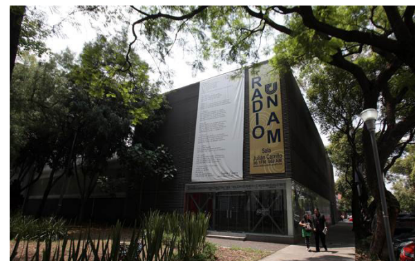
Fig.18. Inmediaciones de las instalaciones de Radio Unam
