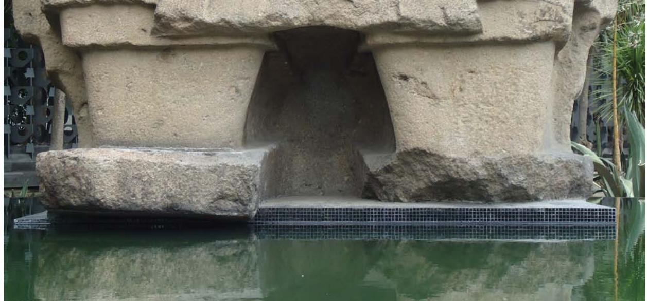
Fig. 94. Vista frontal de la base del monolito de Tláloc
