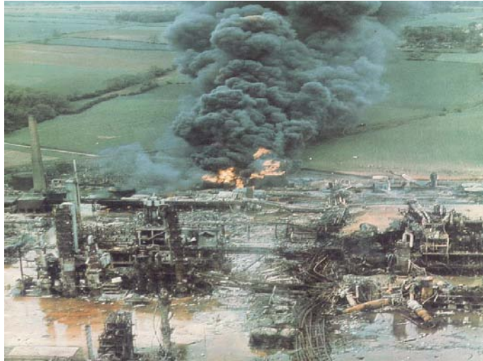
Figura 3.7. Accidente de Flixborough en 1974 (INERCO, 2013).
