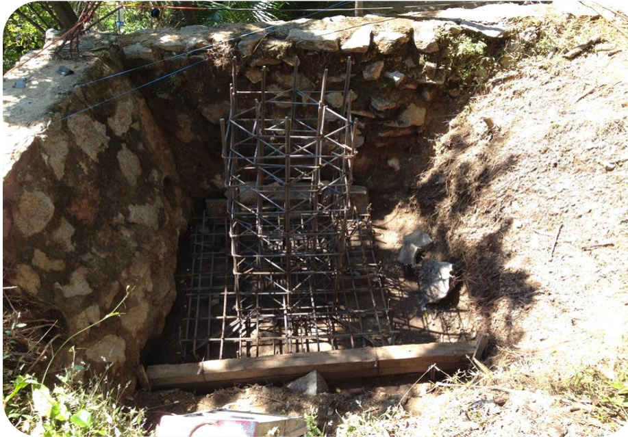
Figura 130. Armado de zapata y dado.
