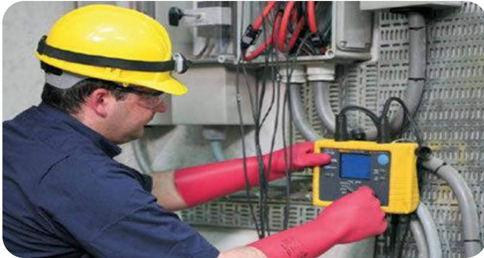
Figura 89. Midiendo flujo de corriente en un centro de carga.
