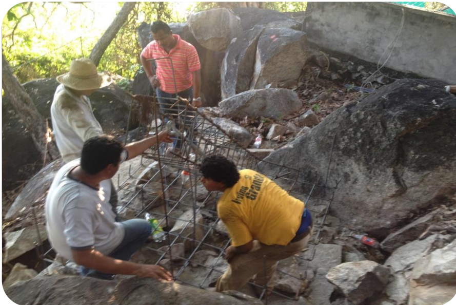
Figura 132. Armado del ancla.
