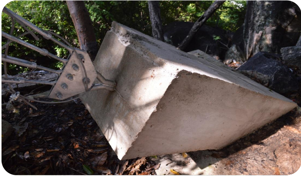
Figura 133. Acabado de zapata para retenida.
