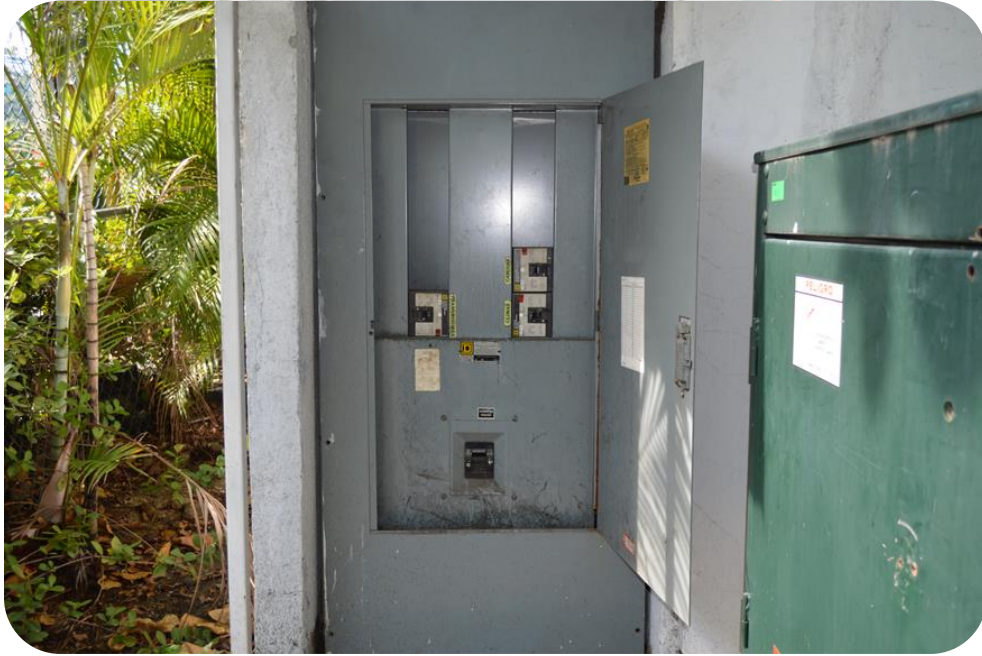
Figura 138. Centro de Cargas principal.
