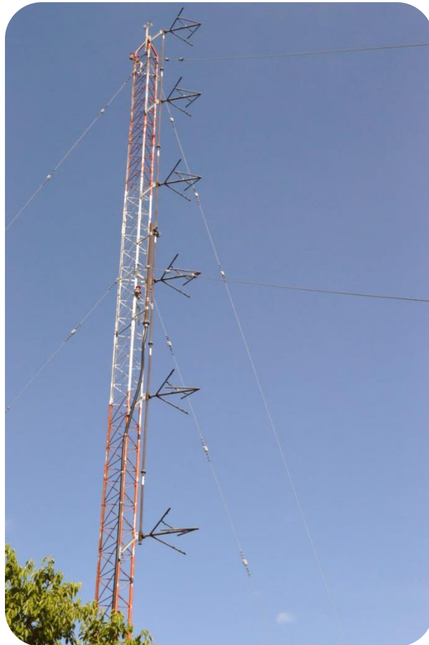
Figura 158. Antena montada sobre la Torre.
