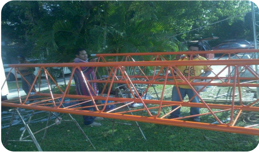
Figura 134. Aplicación de pintura roja y blanca para señalización de torre.
