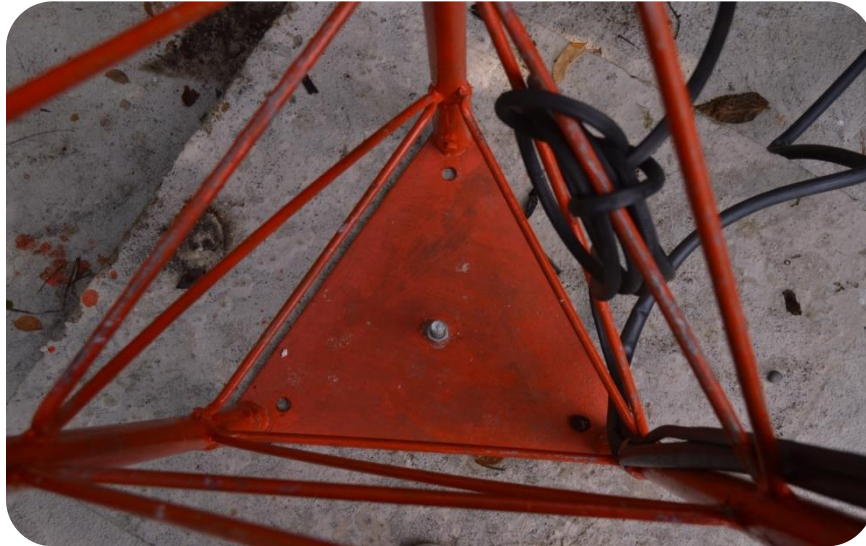
Figura 135. Anclaje de la torre sobre la base de concreto.
