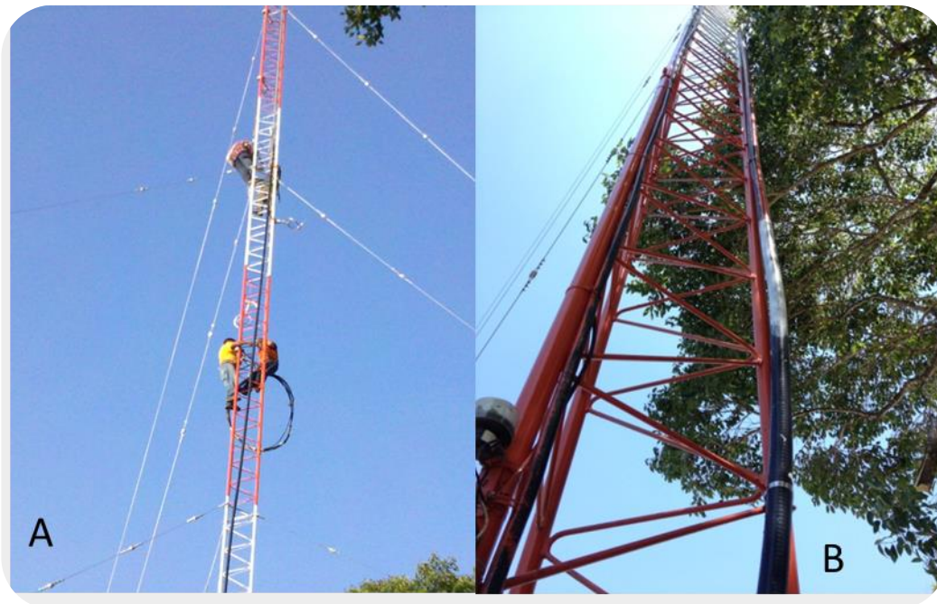
Figura 154. Colocación de la línea de transmisión Heliac de 1 5/8.
