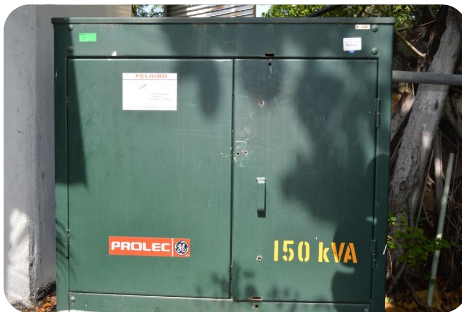
Figura 137. Transformador con capacidad de 150 KVA.
