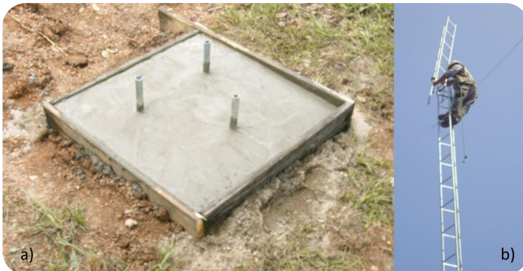
Figura 85. a) Base de torre. B) instalación de torre tramo a tramo.
