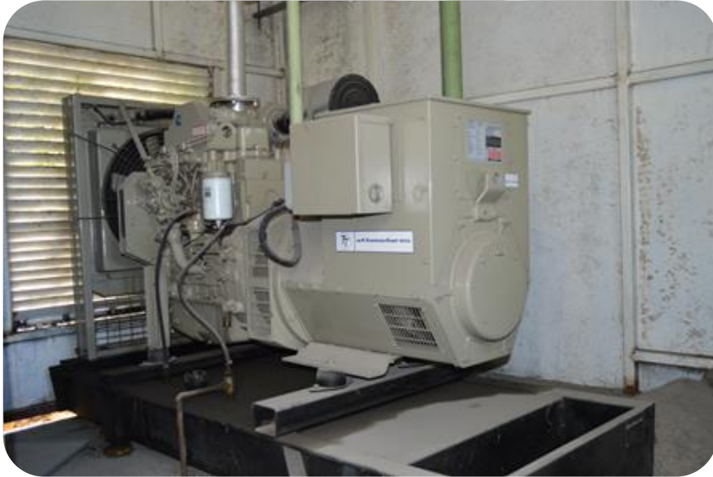
Figura 140. Generador con motor diésel.
