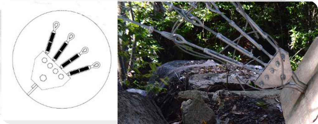
Figura 86. Instalación de sujetadores.
