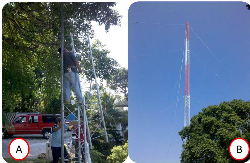
Figura 136. A) Montaje. B) Ajuste de los tensores.
