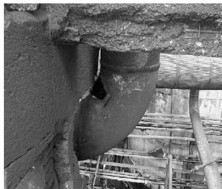
**Figura C.1:** *Sulfuración*
