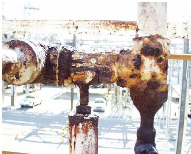
**Figura C.18:** *Corrosión Bajo Aislamiento*
