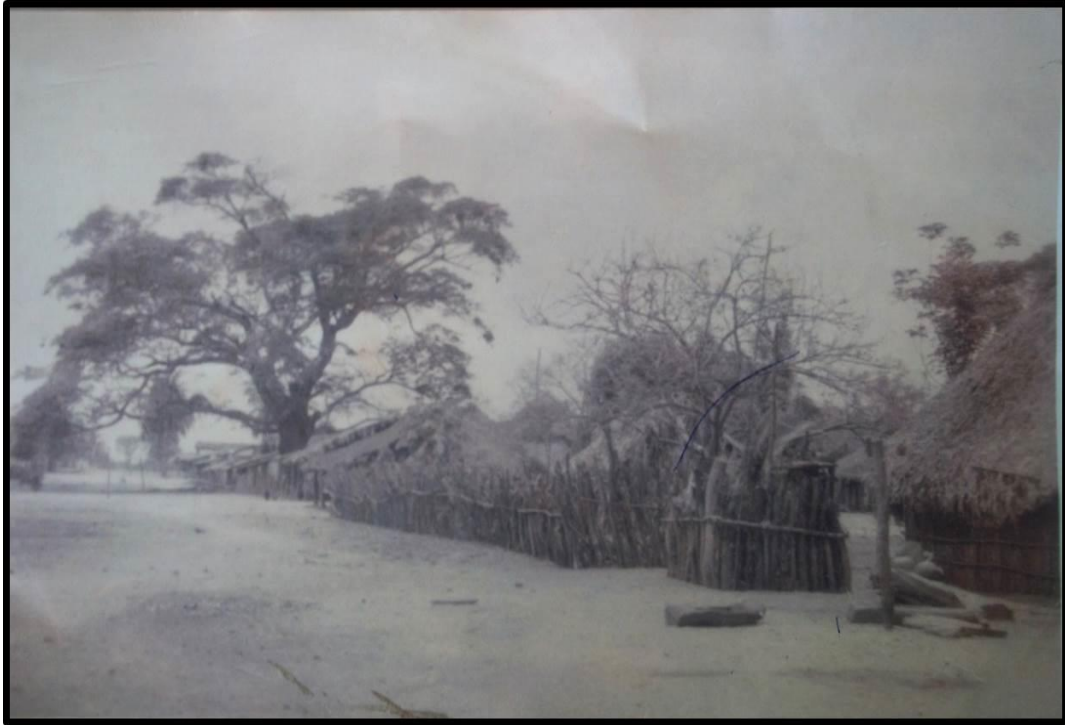
FIG. 20 Casas con techo de palma real (AFFMR, s/f).
