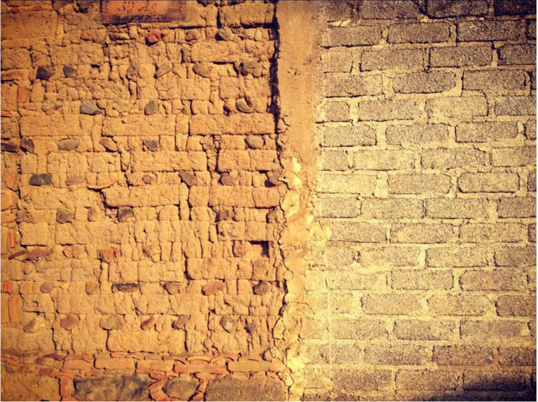
Fig. 39. Contraste de tecnologías y choque entre producción local y producción industrial de los materiales de construcción. Tomada por el autor en Totolapan, Morelos, 2013.
