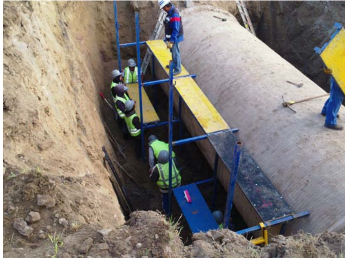
Figura 3.27: Armado de plataforma. Fuente: autoría propia.
