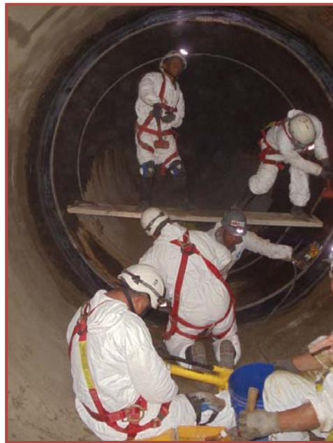
Figura 3.19: Colocación de sellos metal plástico (GIT, 2013).
