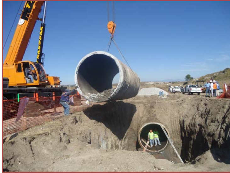
Figura 3.15: Extracción del producto de la desinstalación de los segmentos (GIT, 2013).
