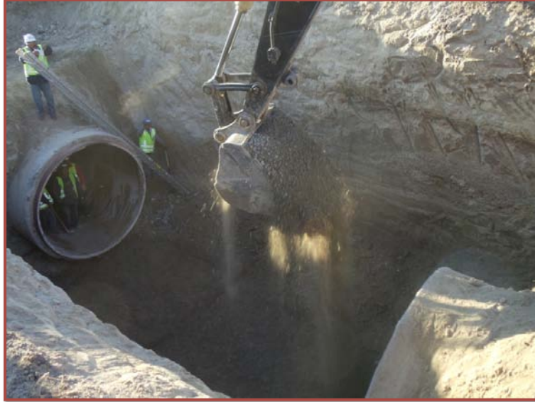
Figura 3.21: Colocación de grava (GIT, 2013).
