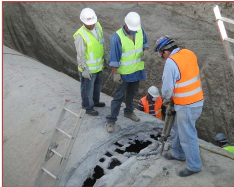
Figura 3.12: Demolición de tubo con equipo neumático (GIT, 2013).
