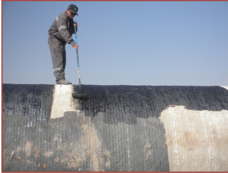
Figura 3.16: Aplicación de pintura en las piezas especiales (GIT, 2013).
