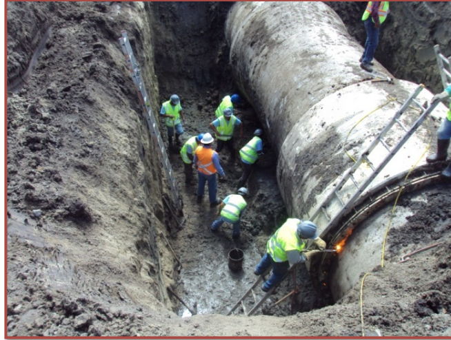
Figura 3.5: Excavación manual (GIT, 2013).
