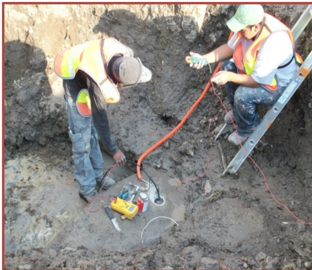
Figura 3.20: Instalación de la protección catódica (GIT, 2013).
