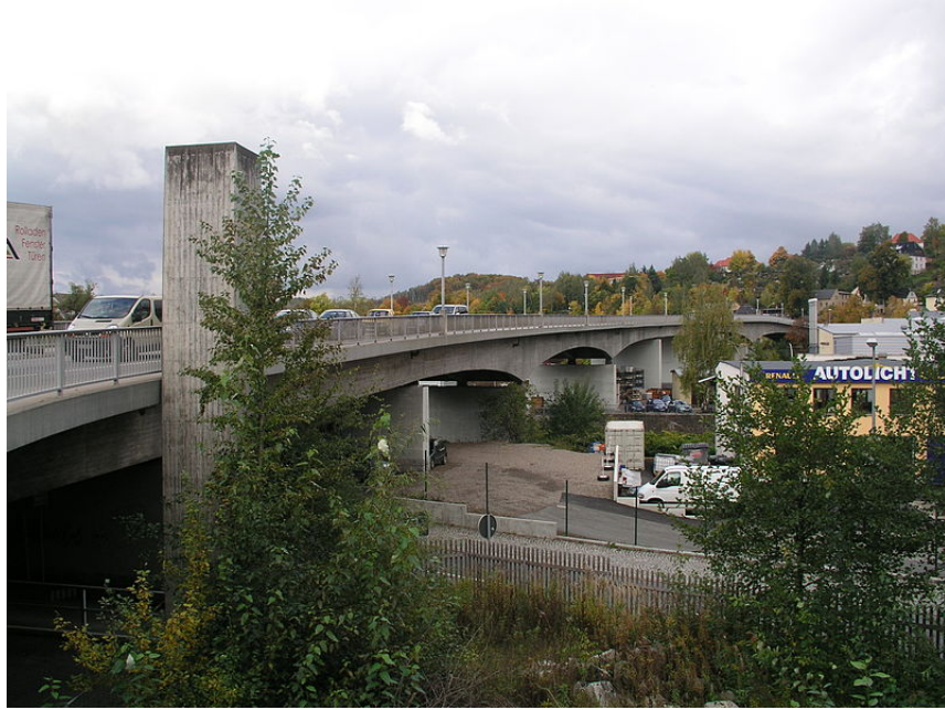
Figura 1.8: Puente Aue Bahnhofsbruecke. Foto tomada de: http://commons.wikimedia.org/ .
