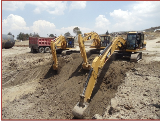
Figura 3.4: Excavación con equipo mecánico (GIT, 2013).
