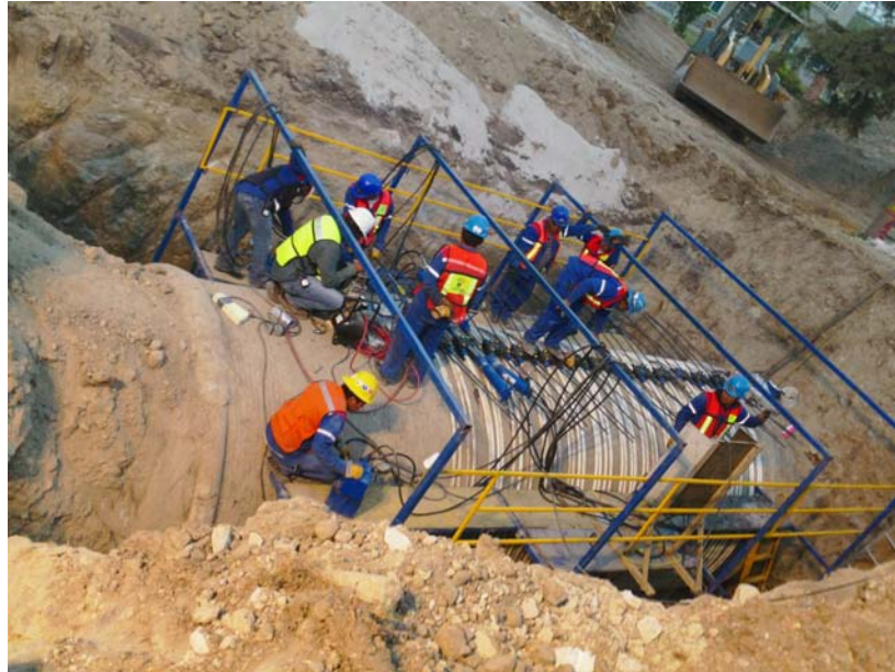
Figura 3.33: Tensado final de torones. Fuente: autoría propia.
