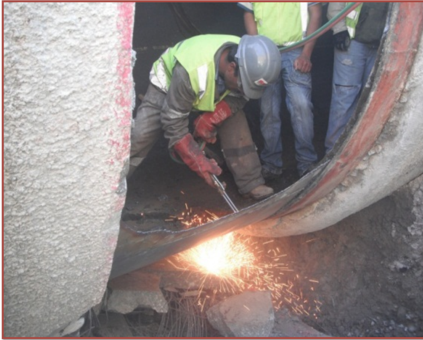
Figura 3.13: Corte de lámina y espiras con equipo de oxicorte (GIT, 2013).
