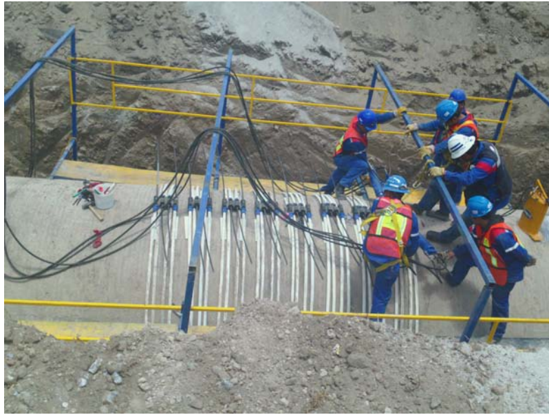
Figura 3.30: Aplicación de precarga (1 tonelada). Fuente: autoría propia.
