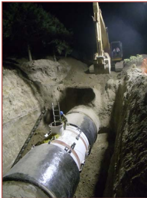
Figura 3.23: Colocación de tepetate (GIT, 2013).
