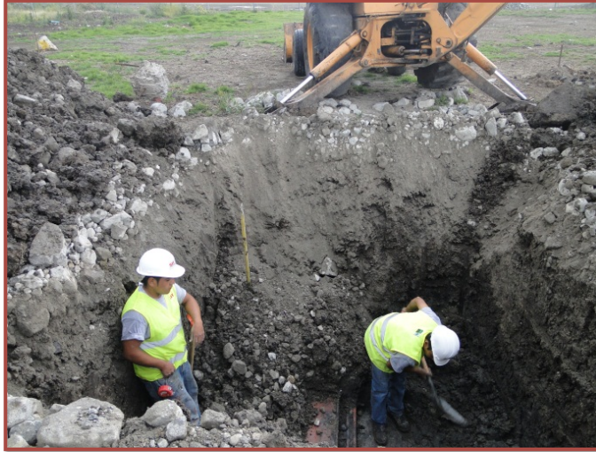
Figura 3.1: Trabajos preliminares: identificación del tubo a sustituir (GIT, 2013).
