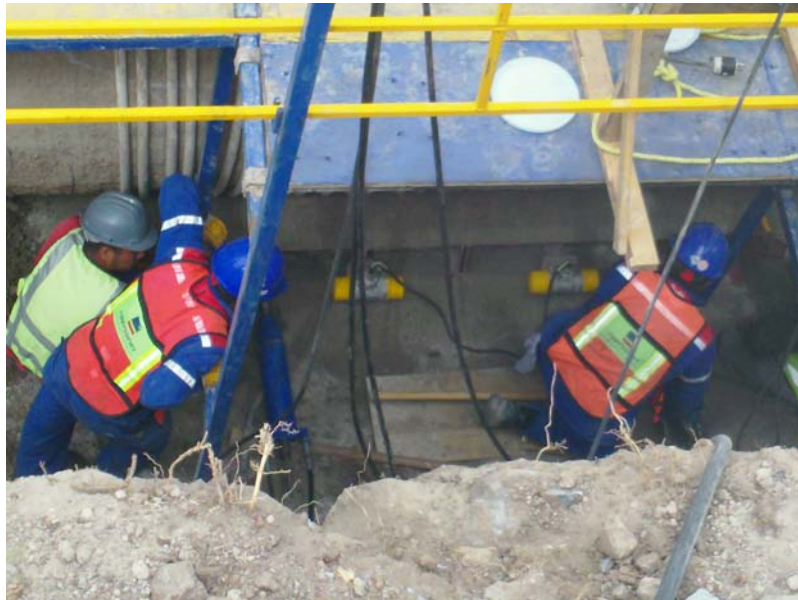
Figura 3.31: Compactación de arena. Fuente: autoría propia.
