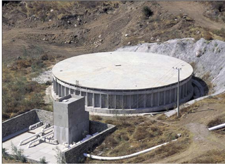
Figura 1.10: Tanque circular para almacenamiento de agua. Atizapán, Estado de México (Fuente: página de Internet de TICONSA).
