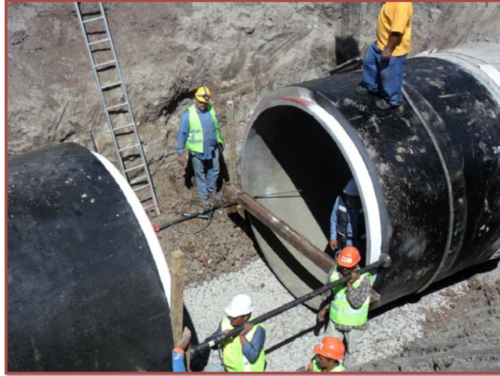
Figura 3.18: Colocación de tensores de acero (GIT, 2013).
