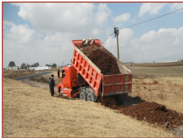
Figura 3.3: Trabajos preliminares: obra de desvío (GIT, 2013).
