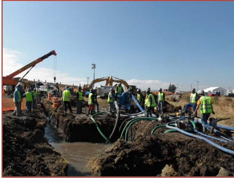
Figura 3.6: Bombeo de achique (GIT, 2013).
