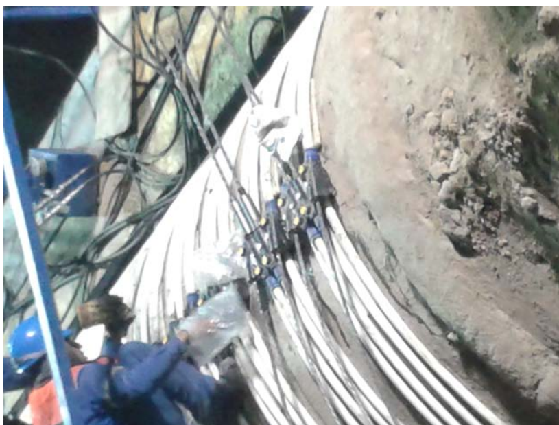
Figura 3.35: Colocación de tapones. Fuente: autoría propia.
