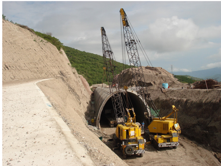
Figura 1.13: Construcción del túnel Chilpancingo en Guerrero (Fuente: página de Internet de SEPSA).
