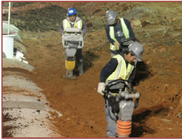
Figura 3.22: Compactación de tezontle (GIT, 2013).
