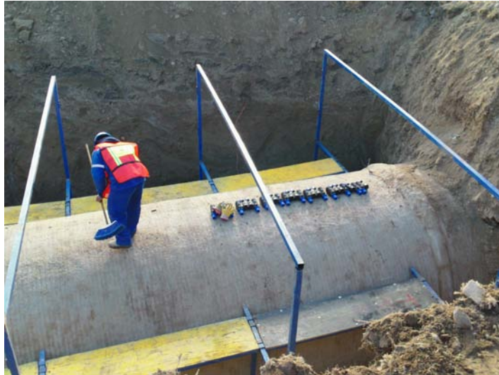
Figura 3.28: Limpieza de tubo y preparación de anclajes. Fuente: autoría propia.
