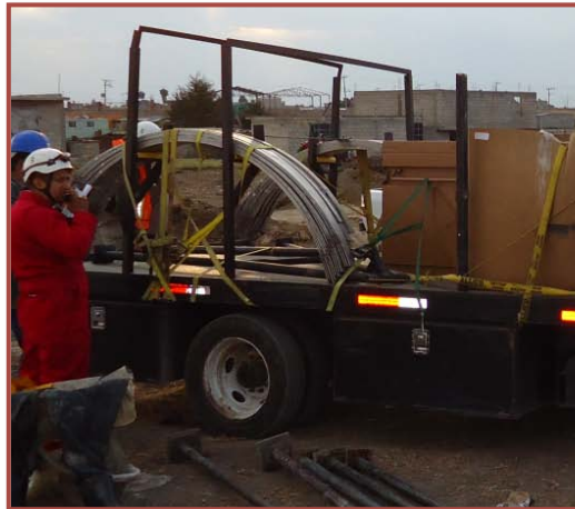
Figura 3.10: Sellos metal plástico de 99" (GIT, 2013).
