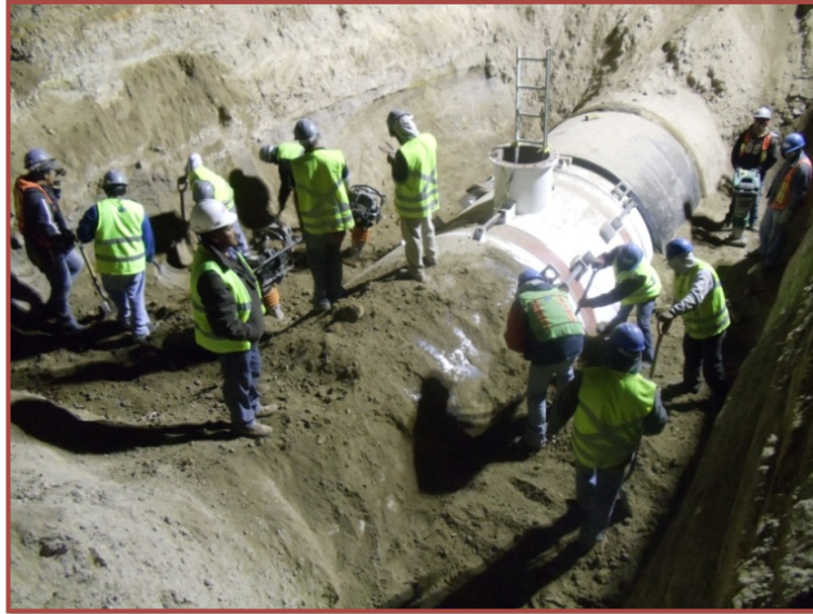
Figura 3.24: Colocación de relleno (GIT, 2013).
