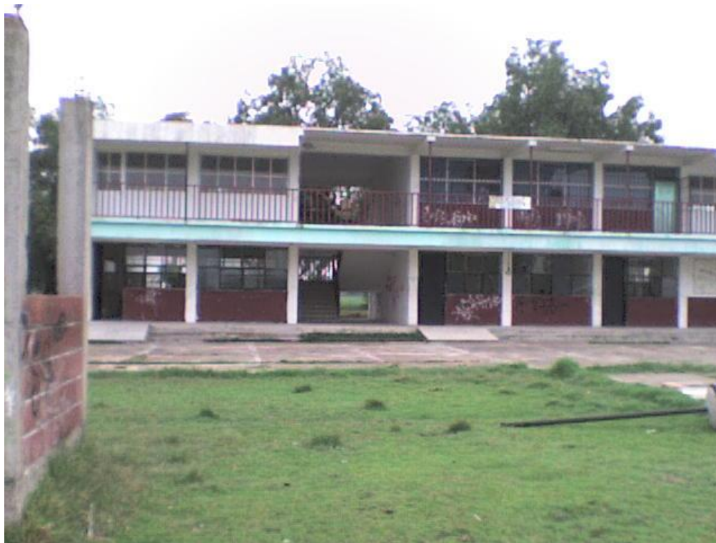
Fotografía 4: Primer edificio. La planta baja fue la primera estructura construida. Actualmente los salones se encuentran en la planta baja y el salón de cómputo en el primer piso (22-Junio-2012)
