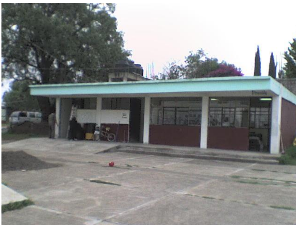
Fotografía 5: Segundo edificio. En el extremo derecho se encuentra la Dirección escolar y en el extremo izquierdo, los sanitarios (22-Junio-2012)
