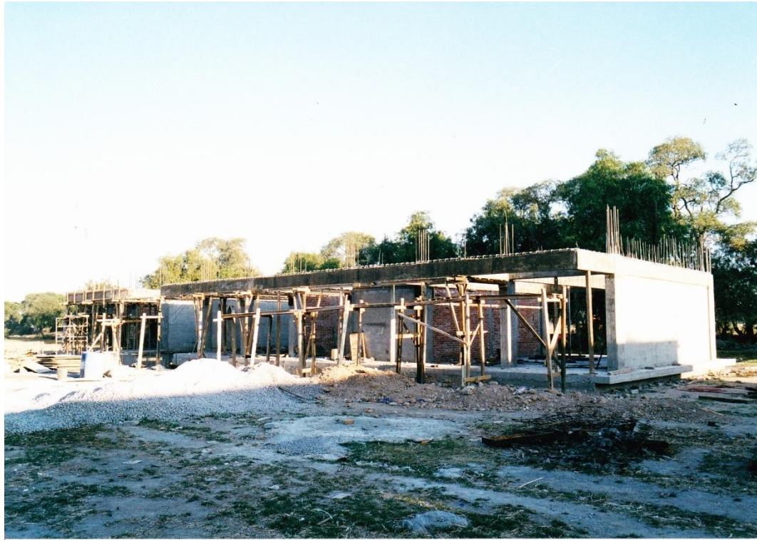
Fotografía 1: Primer edificio en construcción 128
