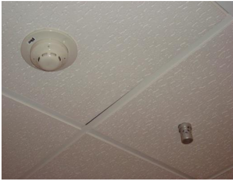
Sistema de detección de humo y dispersión de CO2
