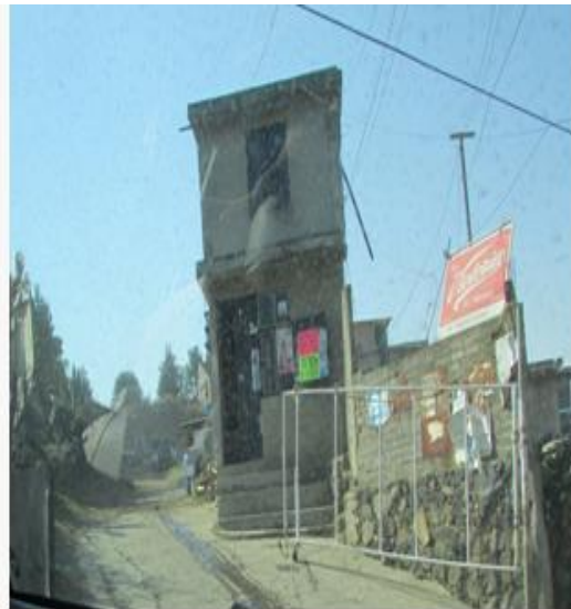
Fotografía tomada durante el reconocimiento de hechos del 31 de enero del 2013. No se pudo observar la acumulación de madera.
