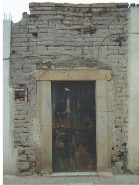
“Fachada de antigua casa de adobe en San José de los Reynoso” 2013 (Fig. 97)
